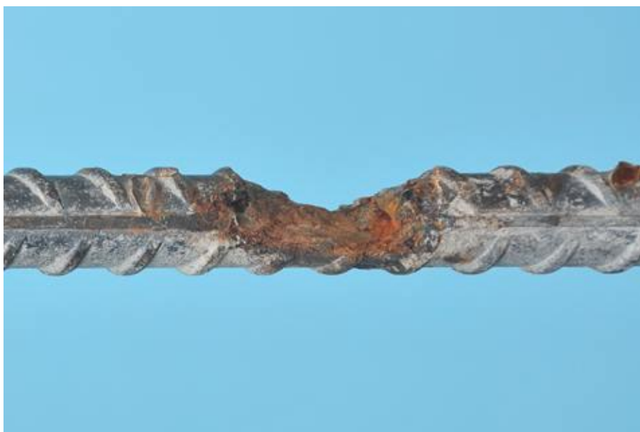
Διάγραμμα 1.8: Βελονοειδής διάβρωση σε χαλύβδινη ράβδο οπλισμού που προκλήθηκε λόγω προσβολής χλωριόντων στο σκυρόδεμα
