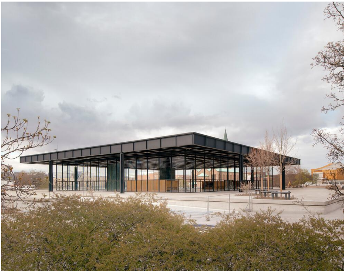
Εικ.39 Ludwig Mies van der Rohe, Neue Nationalgalerie , 1965-1968, Βερολίνο. Εξωτερική άποψη του κτηρίου μετά την πρόσφατη ολική αποκατάσταση του (2021).
