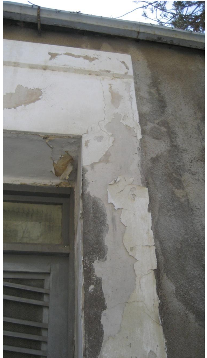
Φωτογραφία 4.2.1.1. : Αποφλοίωση Σκυροδέματος σε οικία στο κέντρο της Παλιάς Λεμεσού
