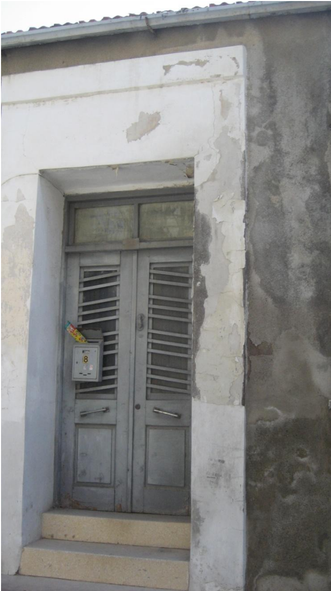
Φωτογραφία 4.2.1.1. : Αποφλοίωση Σκυροδέματος σε οικία στο κέντρο της Παλιάς Λεμεσού
