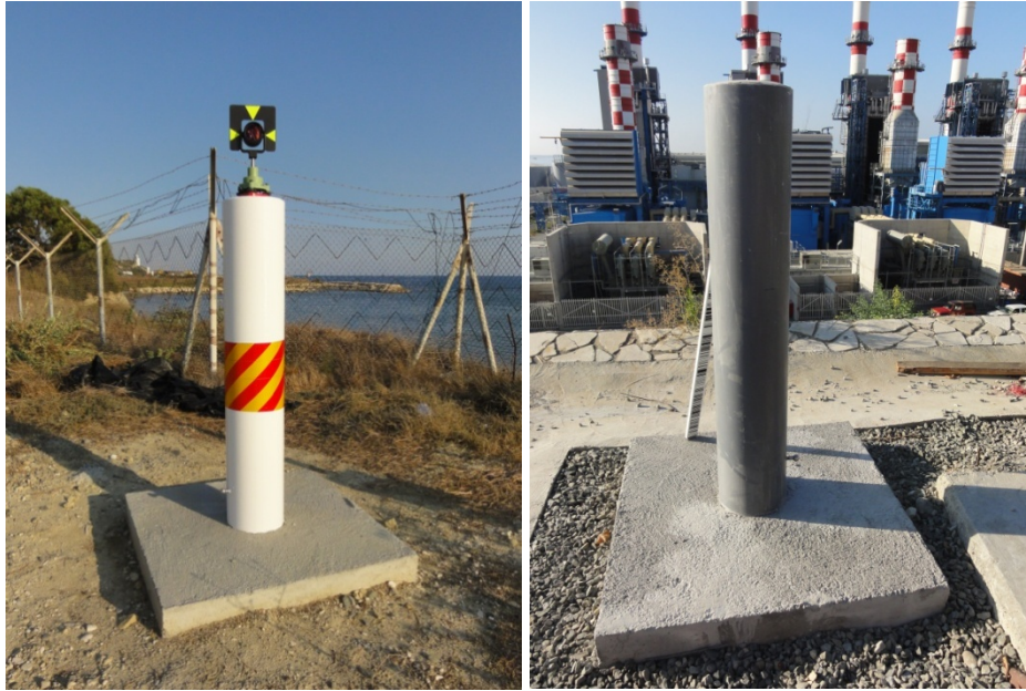
Εικόνα 4: Τσιμεντένιο βάθρο πριν και μετά τη βαφή
