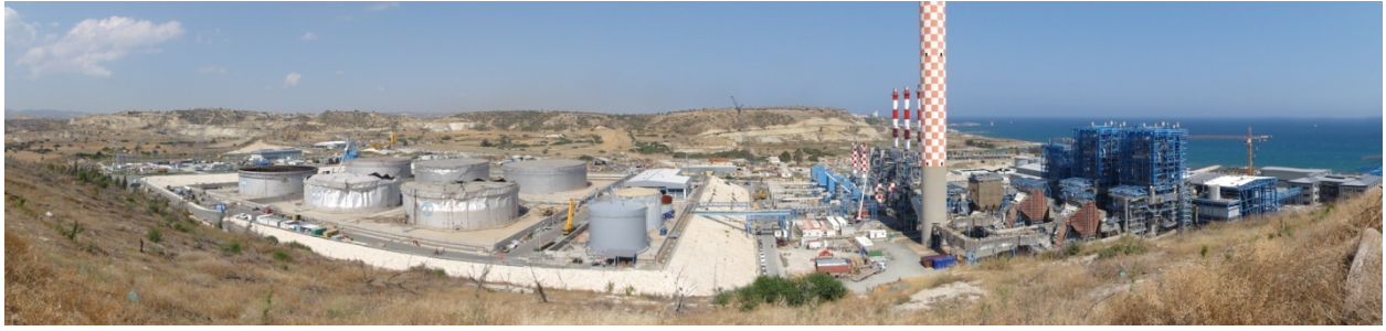
Εικόνα 3: Θερμοηλεκτρικός σταθμός "Βασιλικός" στο Μαρί
