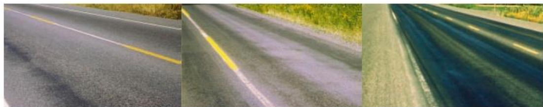
Εικόνα 1.2: Έξαψη (Πηγή: Walker et al. 2002)
