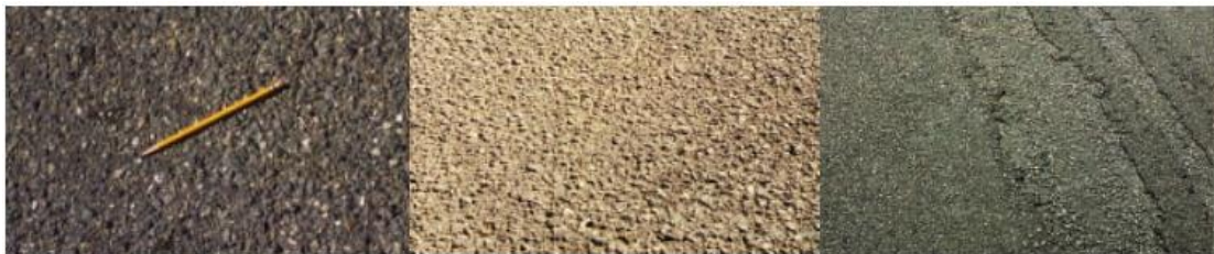
Εικόνα 1.1: Ξέφτισμα (Πηγή: Walker et al. 2002)
