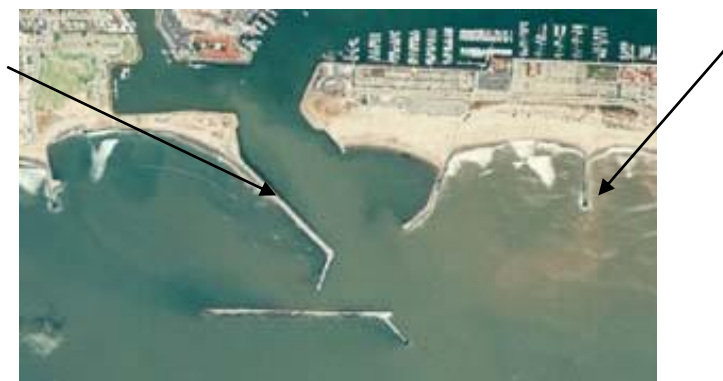
Εικόνα4-7.Βραχίονες για προστασία των ακτών και Jetties για προστασία εκβολών ποταμού.
