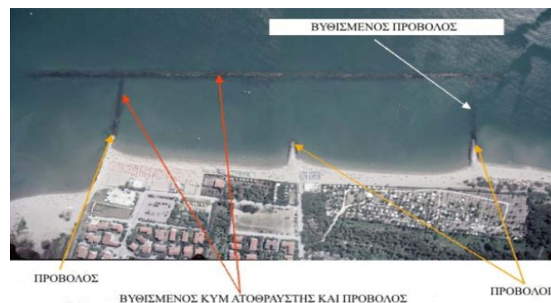
Εικόνα4-5. Αεροφωτογραφία της παραλίας Lido di Dante, στην οποία κατασκευάστηκε ένας μονός βυθισμένος κυματοθραύστης. ( http://hellanicus.lib.aegean.gr )
