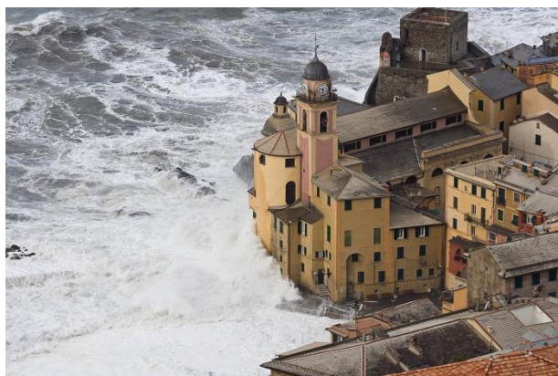
Εικόνα 3-8. Αρκετά μεγάλος βαθμός διάβρωσης όπου θα χρειάζεται Μαρίνα για την αποκατάσταση.
