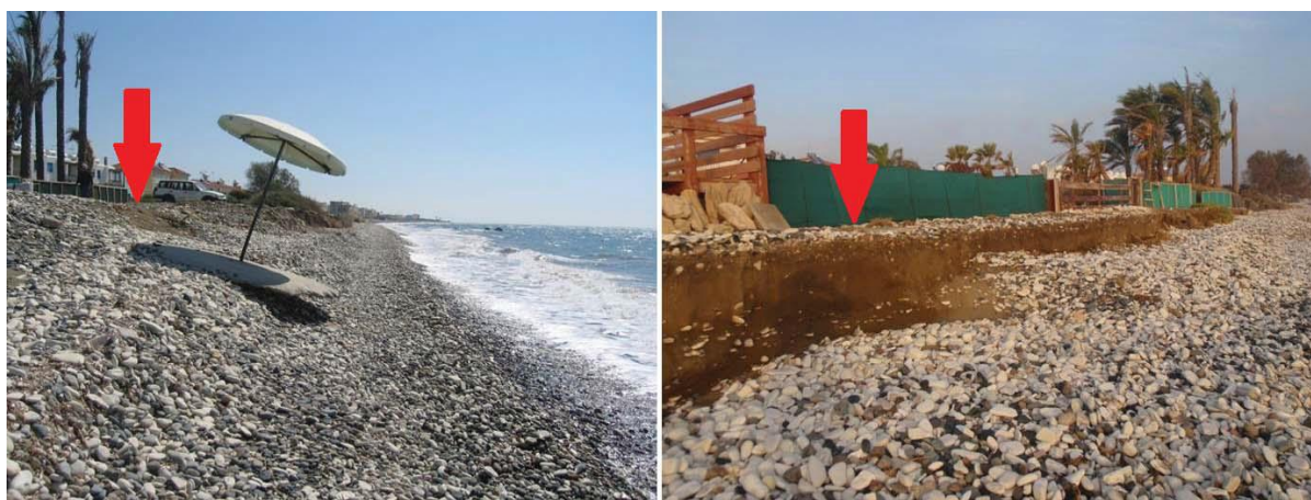
Εικόνα 1-9 Διάβρωση στην περιοχή Περβολιών Λάρνακας μεταξύ των ετών 2007 και Εικόνα 1-10 το 2010
