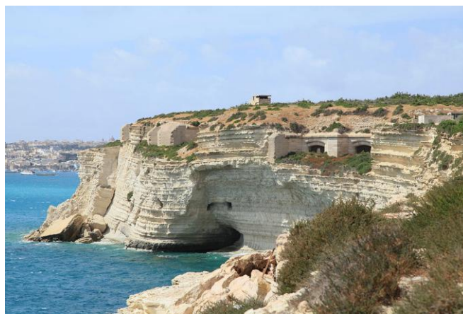
Εικόνα 3-9.Βραχώδεις περιοχή όπου υπέστη διάβρωση.
