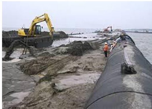
Εικόνα4-15. Κατά την διάρκεια εργαταξίου.( www.geshellas.gr )
