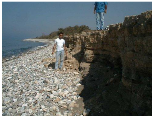
Εικόνα 2-1 Διάβρωση πρανούς στη νότια ακτή της Πάφου (Χα ποτάμι) εξ αιτίας της κατασκευής φραγμάτων. (www.izimata.com)
