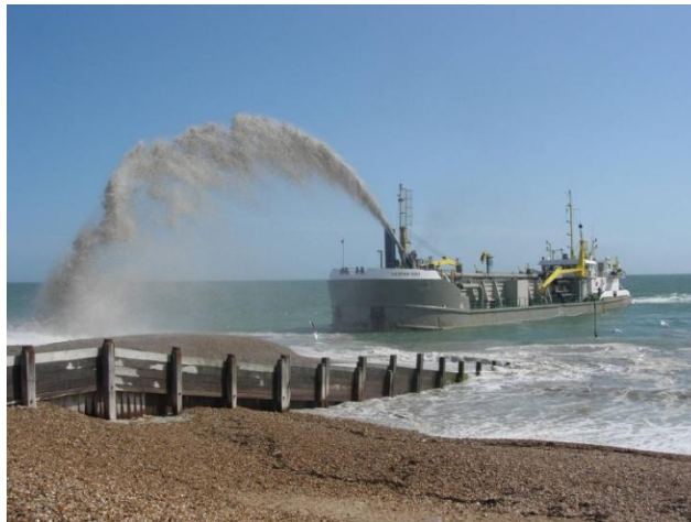
Εικόνα4-15. Εμπλουτισμός Ακτής Μέσω Θαλάσσης.( http://www.escp.org.uk )
