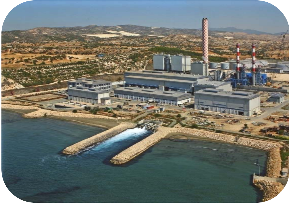
Εικόνα 2 Φωτογραφία του Η/Σ Βασιλικό μετά την κατασκευή της πρώτης φάσης
