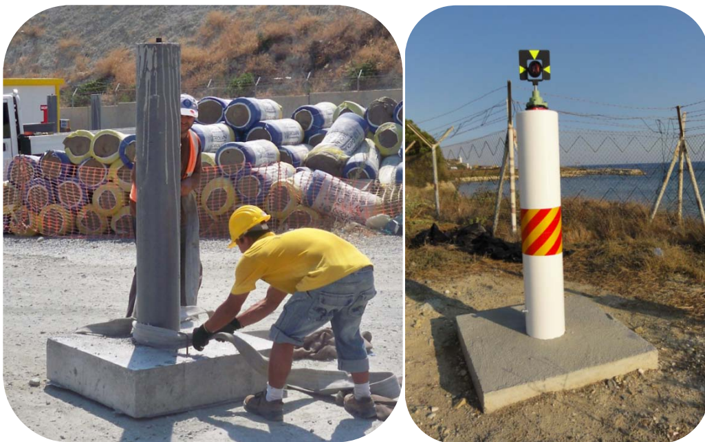
Εικόνα 10 Το βάθρο στο σημείο “3-THALASSA” πριν και μετά το πέρας της υλοποίησης
