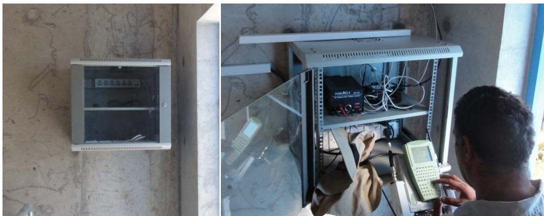
Εικόνα 12 Κατάλληλο κιβώτιο για μόνιμη τοποθέτηση δέκτη GNSS
