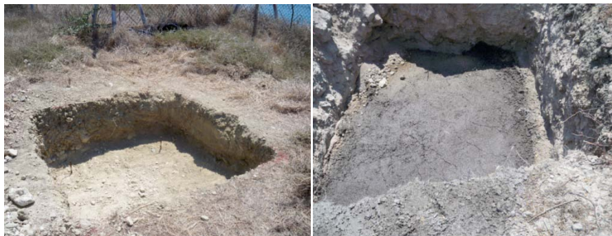
Εικόνα 7 Αριστερά –Εκσκαφή πλάτους 1.5 x 1.5 m για βάρου που βρίσκεται σε σταθερό έδαφος,, Δεξιά - Το σκυρόδεμα εξομάλυνσης ρείθρου
