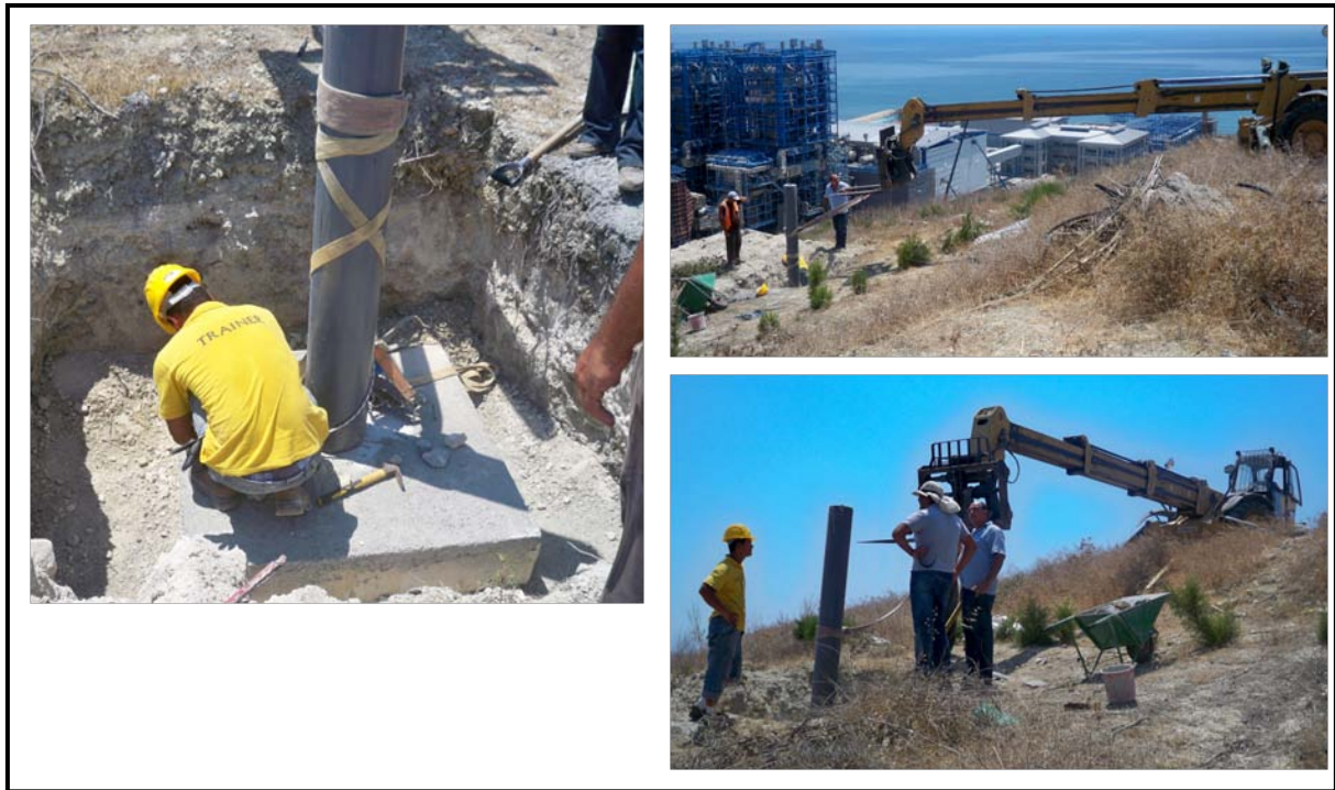
Εικόνα 9 Τοποθέτηση ενός από τα βάθρα στη θέση του
