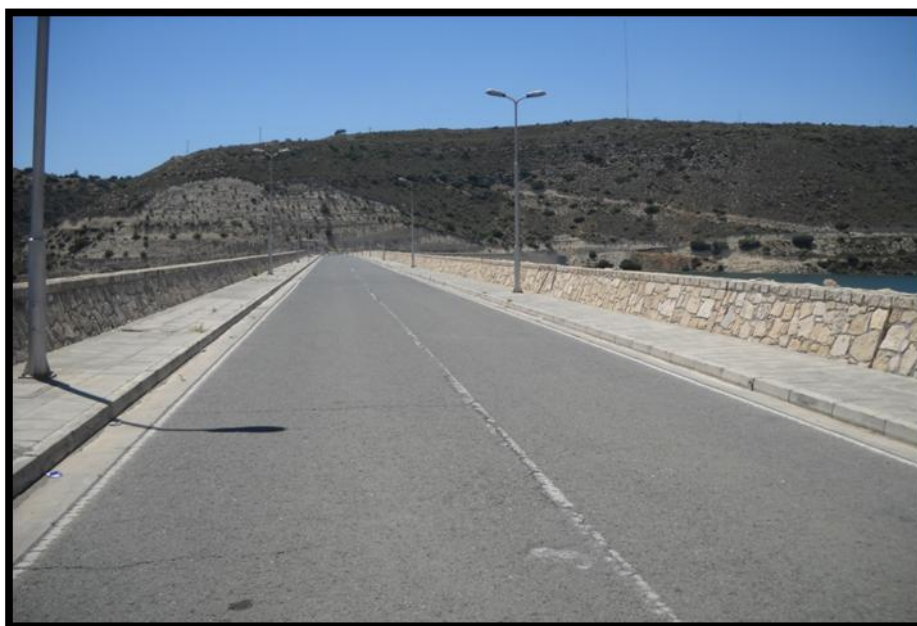
Εικόνα 2.1: Υφιστάμενος δρόμος στη στέγη του φράγματος
