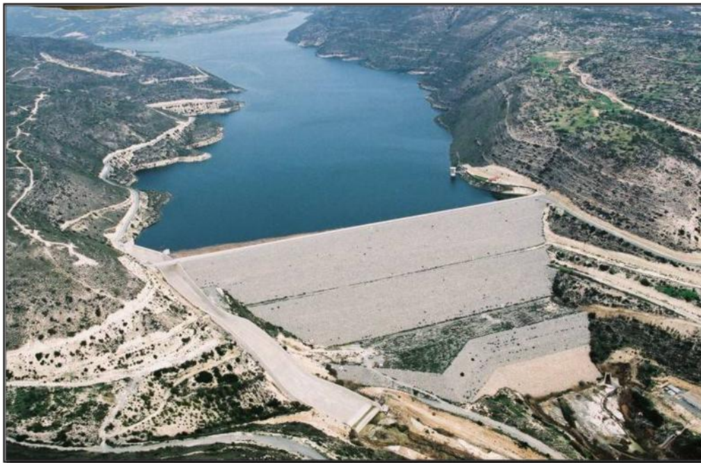
Εικόνα 1.1: Το φράγμα του Κούρη
