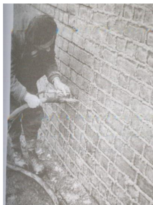
Εικόνα 156: Εισαγωγή κονιάματος
