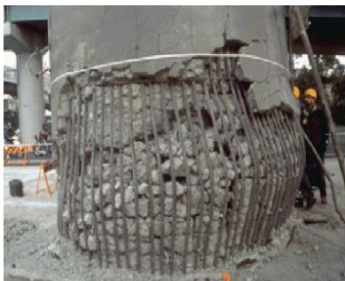
Εικόνα 96: Καμπτοδιατμητική αστοχία με σύνθλιψη.
