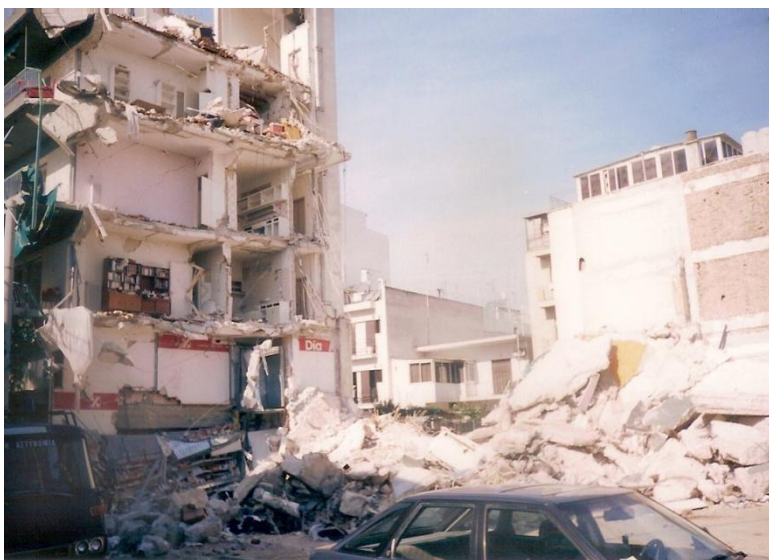
Εικόνα 98: Κατάρρευση τμήματος πολυκατοικίας λόγω μετακίνησης υποστυλώματος στο υπόγειο (σεισμός Αθήνας 1999)
