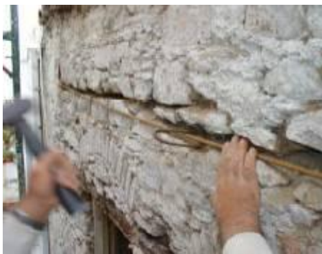
Εικόνα 159: Τοποθέτηση ριζοπλισμών
