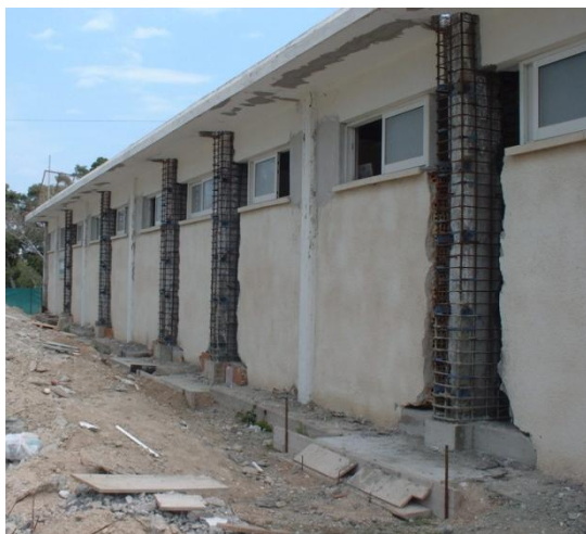
Εικόνα 106: Διορθώσεις κοντών υποστυλωμάτων με κατασκευή τοιχοπλήρωσης εκατέρωθεν του κοντού υποστυλώματος (Δημοτικό Ακρωτηρίου)
