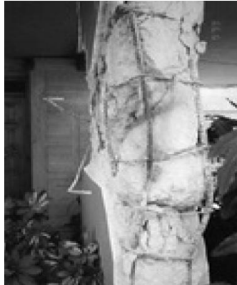
Εικόνα 88: Διακοπή συνέχειας υποστυλώματος λόγω πλήρους αποδιοργάνωσης του σκυροδέματος και βλάβης του διαμήκους και του εγκάρσιου οπλισμού.
