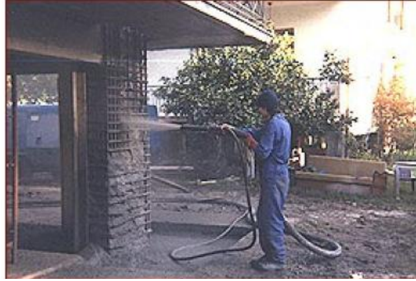
Εικόνα 126: Χρήση εκτοξευμένου σκυροδέματος.
