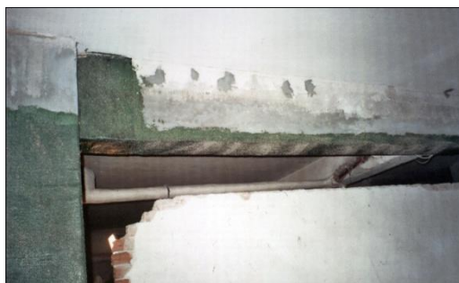
Εικόνα 137: Ενίσχυση υποστυλώματος και δοκού με ανθρακονήματα
