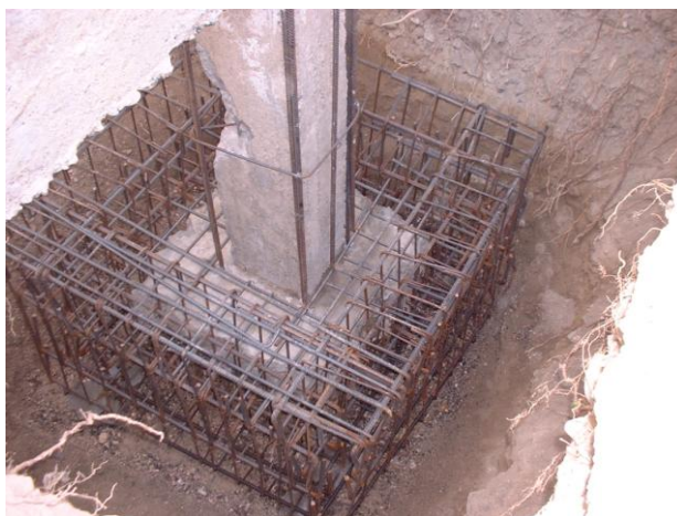
Εικόνα 81: Ενίσχυση υφιστάμενου πεδίου (Γυμνάσιο Κάτω Πύργου)
