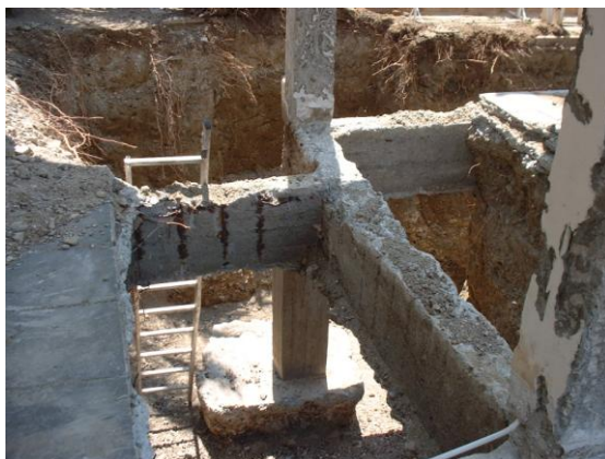
Εικόνα 80: Εντοπισμός υποκολώνων στο Γυμνάσιο Κάτω Πύργου.
