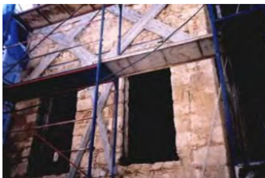
Εικόνα 170: Ανθρακονήματα σε τοιχοποιία
