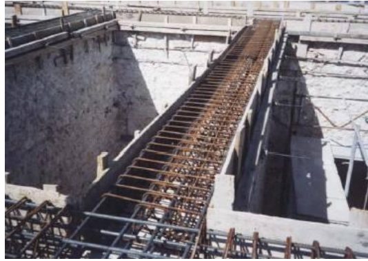
Εικόνα 168: Κατασκευή οριζόντιου διαζώματος σε στάθμη στέγης
