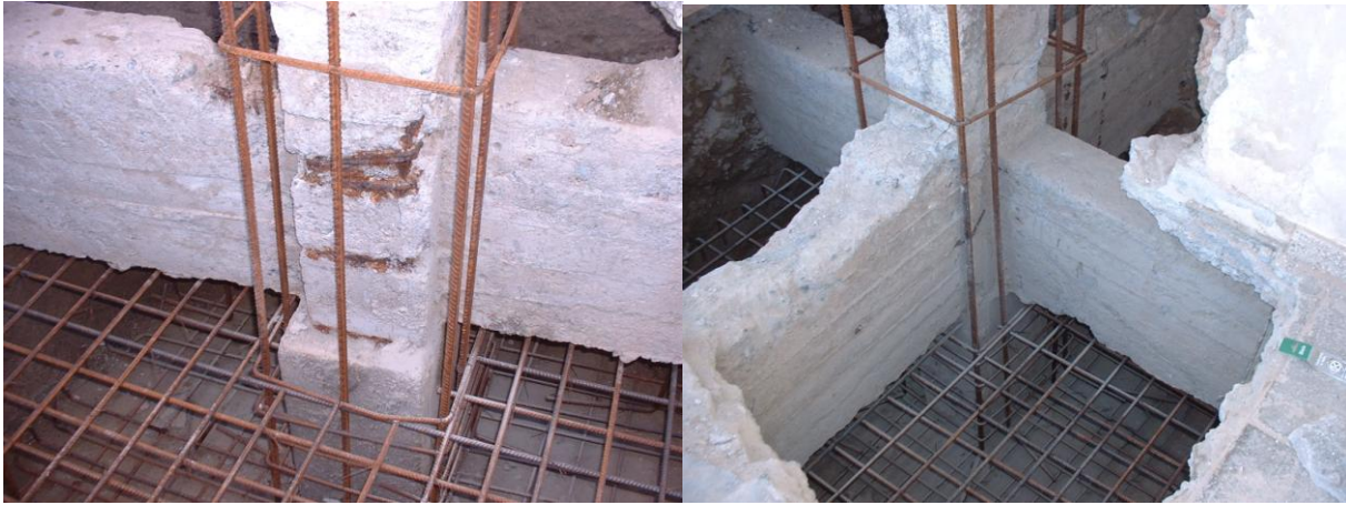
Εικόνα 82: Ενίσχυση υποκόλωνα με την κατασκευή πεδίου (Γυμνάσιο Κάτω Πύργου)
