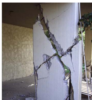
Εικόνα 95: Διατμητική αστοχία τοιχείου με μεγάλες παραμορφώσεις.
