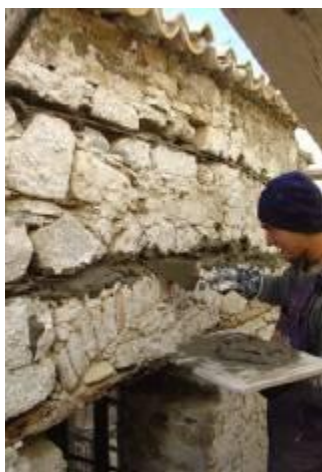
Εικόνα 160: Εισαγωγή κονιάματος
