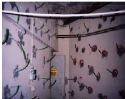
Εικόνα 146: Εφαρμογή ενεμάτων
