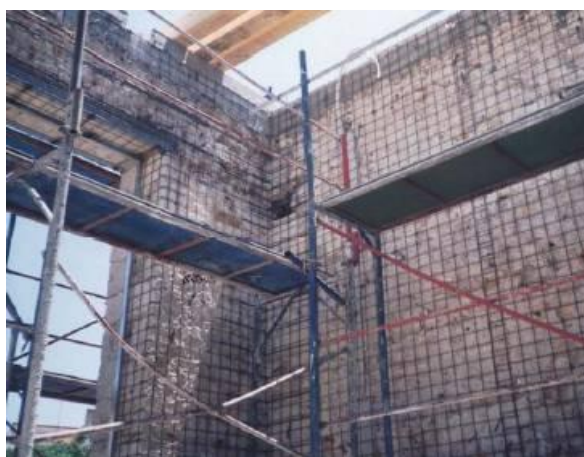
Εικόνα 161: Ενίσχυση τοιχοποιίας με μανδύες Ο/Σ
