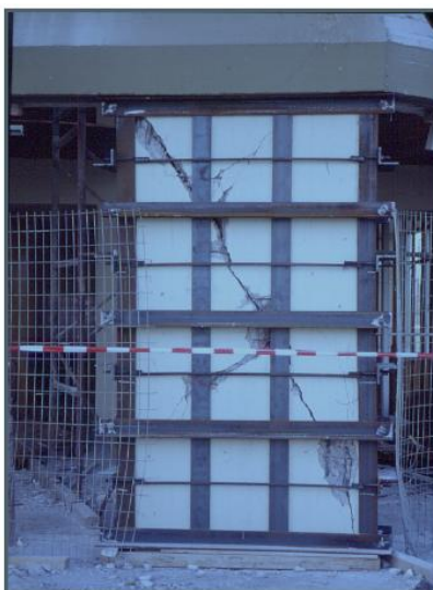
Εικόνα 123: Επέμβαση με μεταλλικό κλωβό για προσωρινή ανάληψη κατακόρυφων φορτίων.
