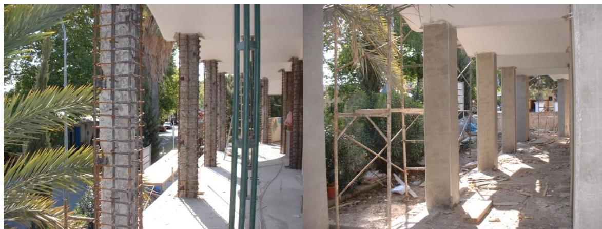
Εικόνα 124: Ενίσχυση υποστυλωμάτων με τετράπλευρους μανδύες (Δημοτικό Κάτω Πύργου).
