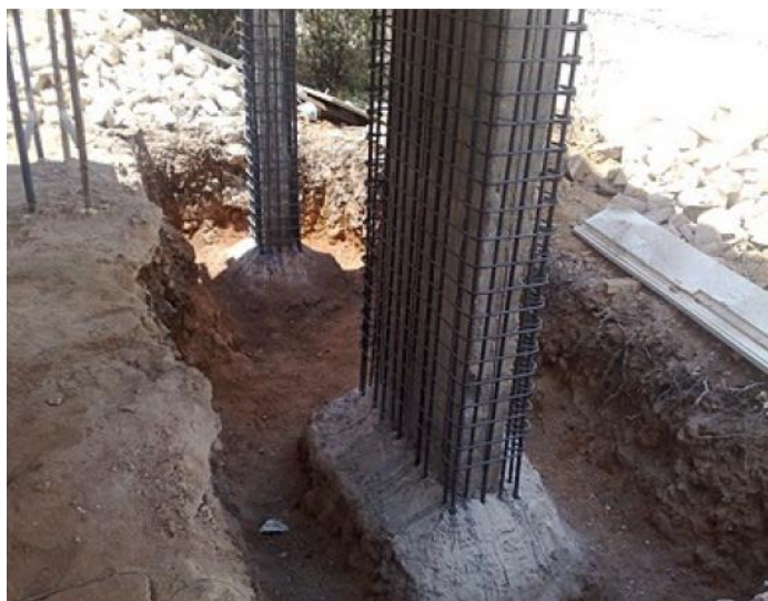
Εικόνα 127: Παράδειγμα αγκύρωσης οπλισμού υποστυλώματος πάνω σε πέδιλο.
