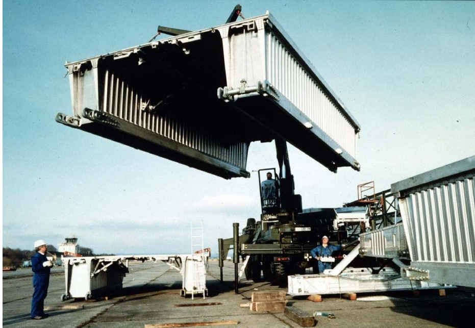
Εικόνα 14: Η Γερμανική στρατιωτική γέφυρα: φάση ανέγερσης
