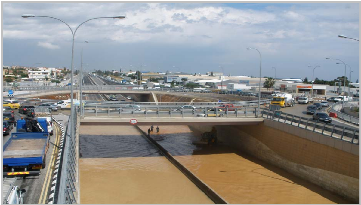
Εικόνα 39. Υπερχειλίση συστήματος Όμβριων Υδάτων
