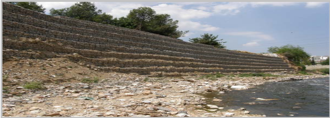
Εικόνα 37. Τοποθέτηση προκατασκευασμένων συρματοκιβωτίων για στήριξη του πρανούς τα συρματοκιβώτια και τα επιχώματα λιθορριπής (Εικόνα 37).
