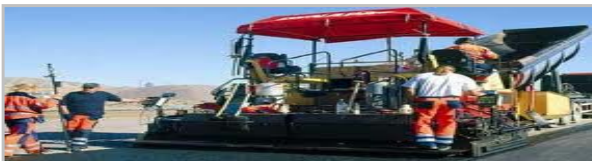
Εικόνα 24. Διάστρωση Ασφαλτικού Τάπητα
