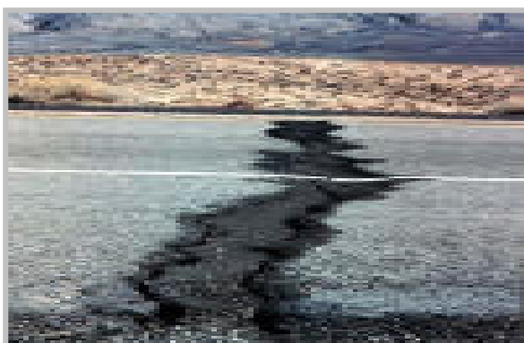
Εικόνα 8. Επιδιόρθωση κάθετης αυλάκωση
