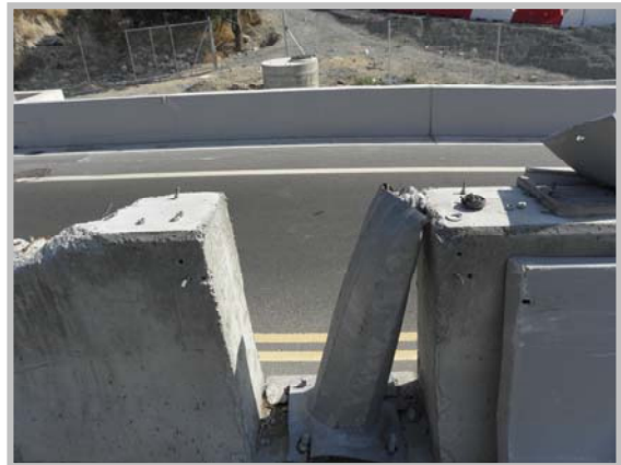
Εικόνα 22 .Ζημιές σε ηλεκτρικό πάσσαλο και Ηχοπετάσματα
