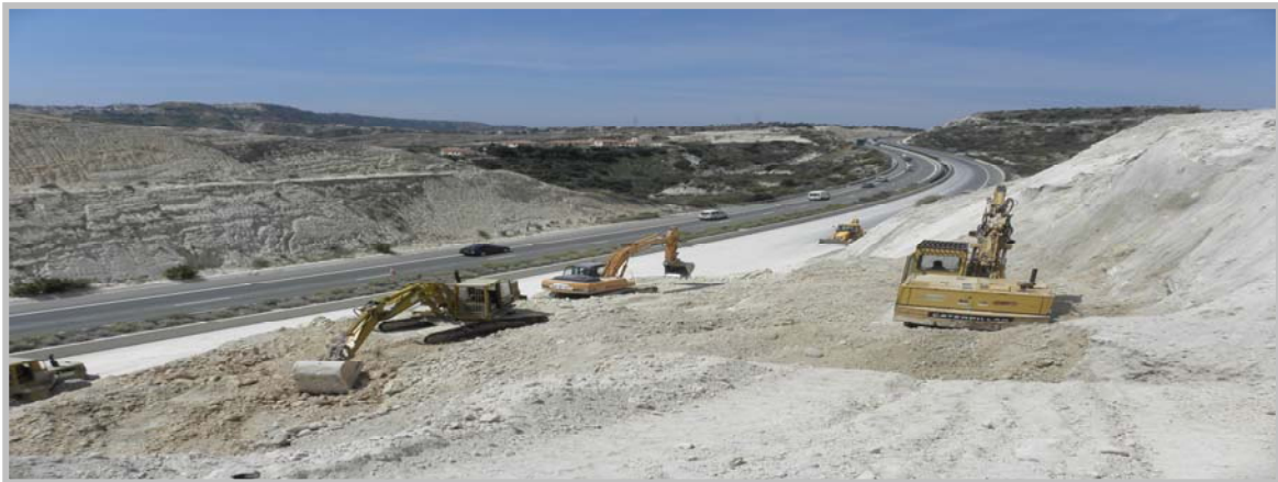
Εικόνα 38. Μόρφωση πρανών μετά από πτώση του στον Αυτοκινητόδρομο
