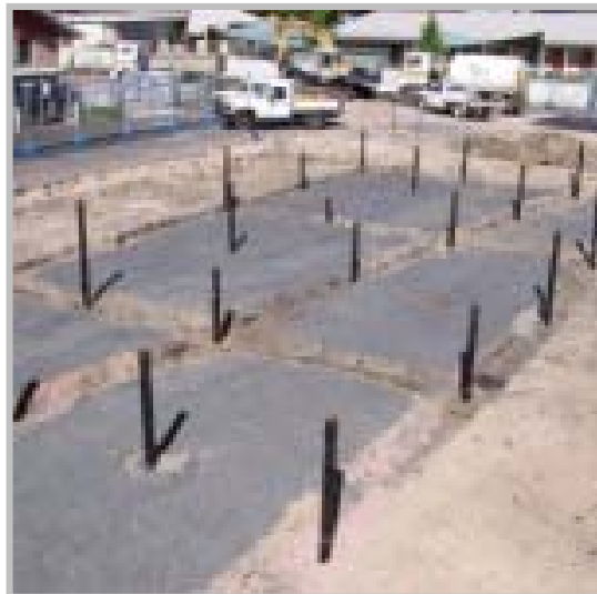
Εικόνα 27. Τετραγωνική βίδα από οπλισμένο σκυρόδεμα Εικόνα 28. Μεταλλική βίδα τοποθετημένη
