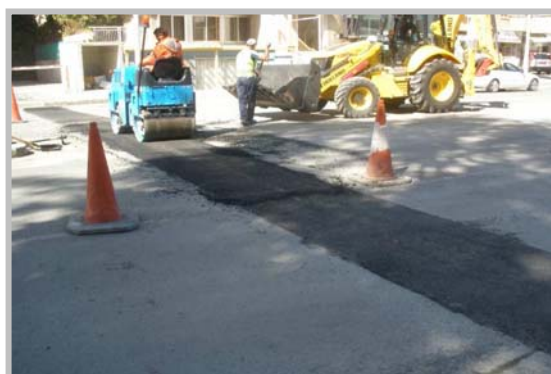
Εικόνα 9. Πλήρωση βυθίσματος
