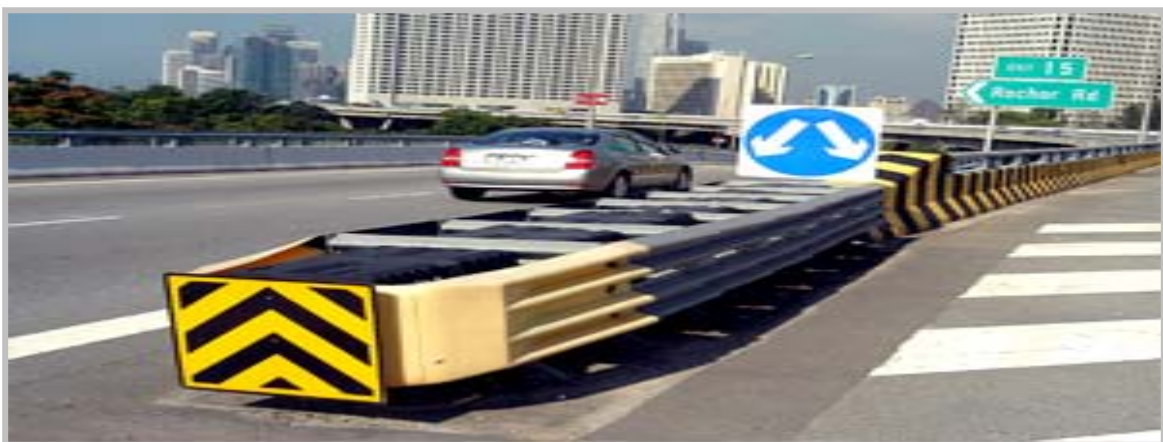
Εικόνα 50. Crash Cushion ή Απορροφητής κινητής ενέργειας
