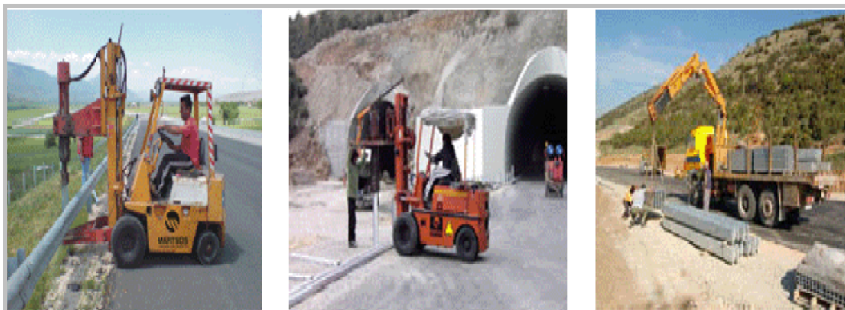
Εικόνα 48. Διαδικασία τοποθέτηση σηθαιών στο εξωτερικό έρεισμα
