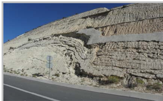
Εικόνα 35. Φθορές σε φυσικά πρανές μετά τη ολοκλήρωση των εργασιών της Οδού
