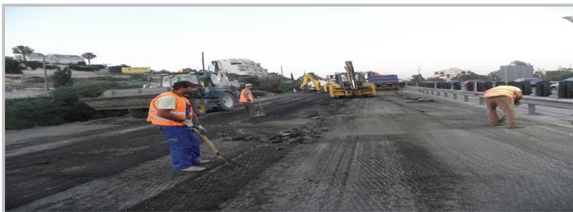
Εικόνα 23. Χρήση μηχανημάτων χειρός στην απόξεση
