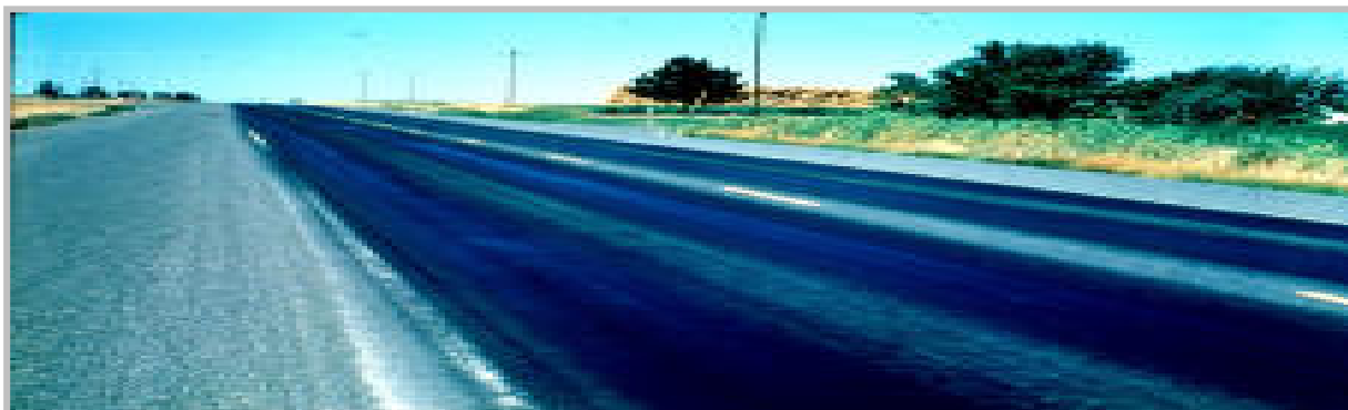
Εικόνα 18. Ανάδυση υλικού
