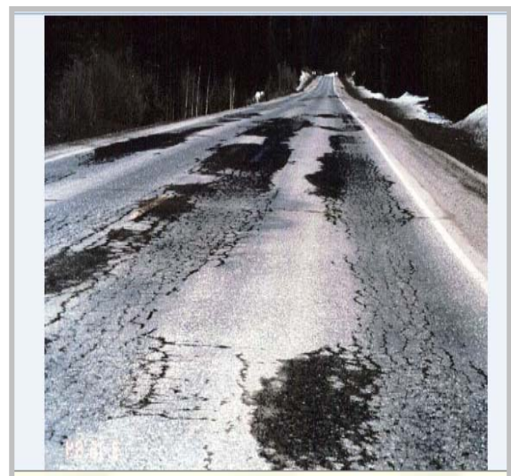
Εικόνα 11. Αποτέλεσμα της Δράση του παγετού
