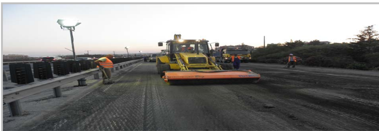
Εικόνα 22. Απόξεση και απομάκρυνση επιφανειακών στρώσεων
