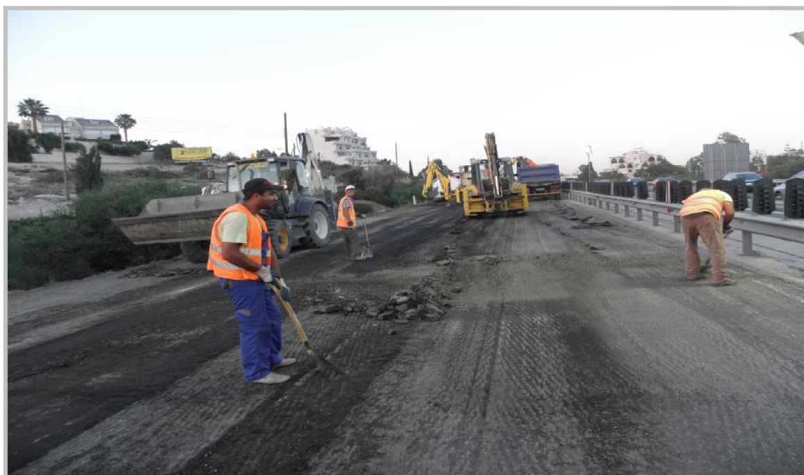
Εικόνα 11. Χειρονακτική απόξεση των επιφανειακών στρώσεων
