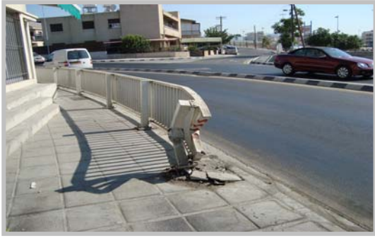
Εικόνα 21 Ζημιές σε κυκλίδωμα Διάβασης Πεζών
