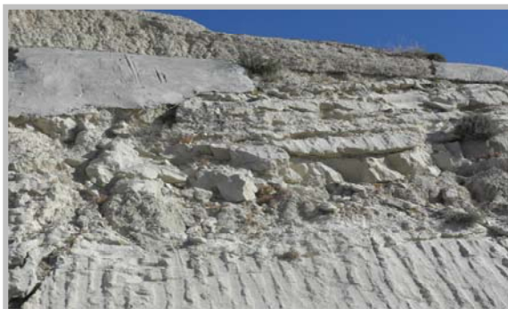
Εικόνα 35. Φθορές σε φυσικά πρανές μετά τη ολοκλήρωση των εργασιών της Οδού
