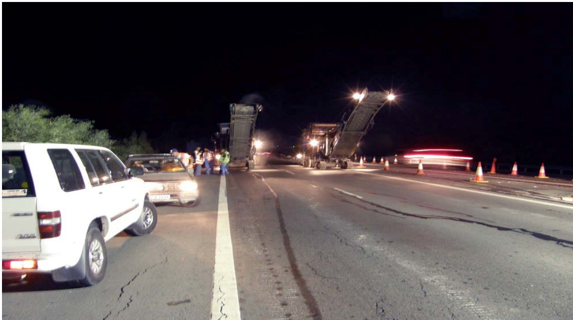
Εικόνα 9. Ειδικά μηχανήματα απόξεση
