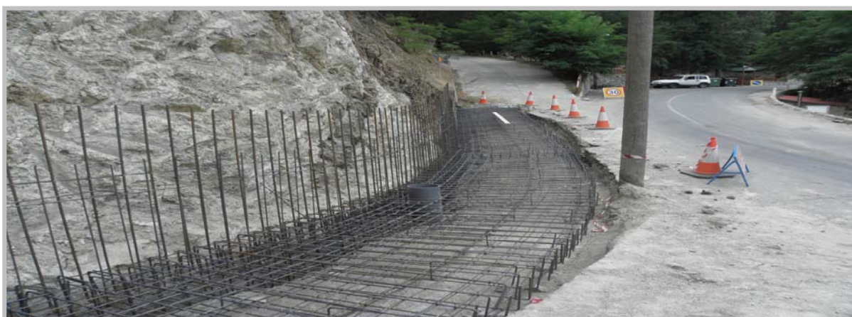
Εικόνα 36. Τοίχος Αντιστήριξης του πρανούς ως μέτρα σταθεροποίησης της Οδού
