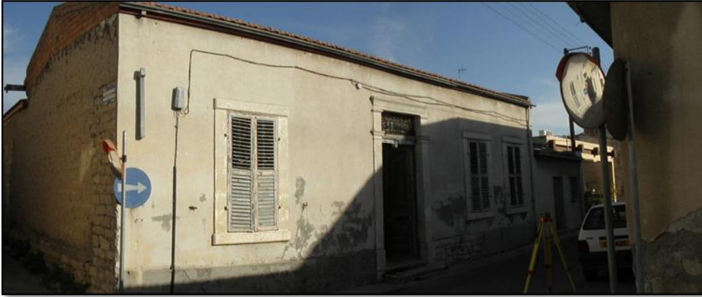
Εικόνα 22. Αποψη κτιρίου προς μελέτη.
