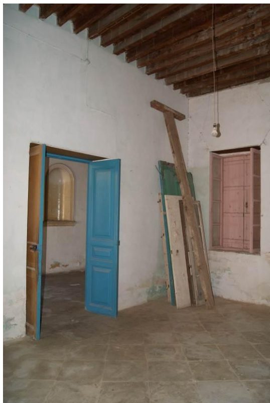
Εικόνα 10. Αποψη θύρας και δωματίου 103.
