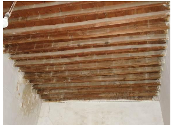
Εικόνα 16. Τεγίδες στέγης δωματίου 102.
