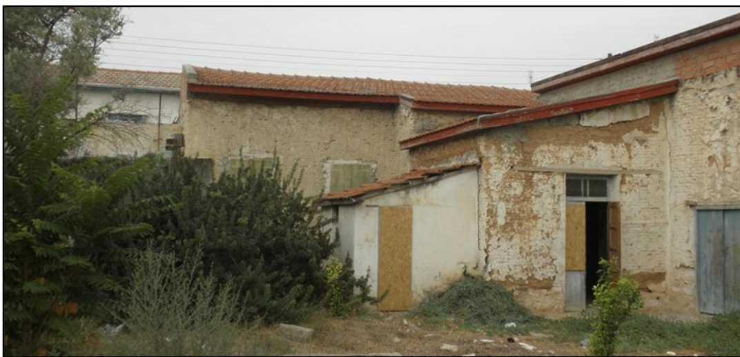
Εικόνα 51 Άποψη κτιρίου από την νοτιοανατολική πλευρά (προσθήκες κτισμάτων)
