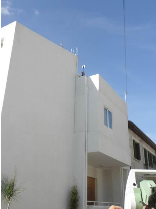
Εικόνα 17. Άποψη δώματος γειτονικού κτίσματος από όπου έγινε σάρωση της στέγης του υπό μελέτη κτιρίου.
