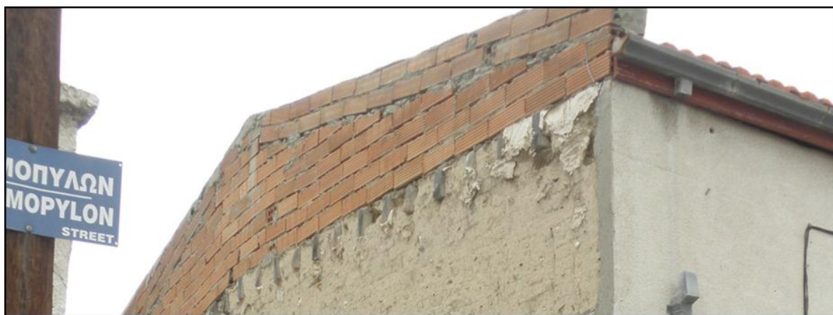
Εικόνα 56. Σύνδεση διαφορετικών υλικών τοιχοποιίας. (Εικόνα Α) Πηγή : Προσωπικό αρχείο.
