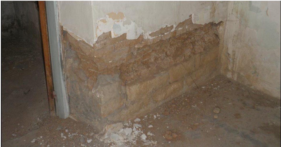
Εικόνα 19. Αποκάλυψη σοβά για εκτίμηση κατάστασης τοιχοποιίας.
