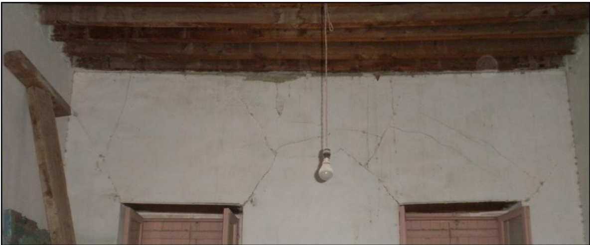
Εικόνα 54. Ρωγμές πάνω από τα παράθυρα του δωματίου 103.
