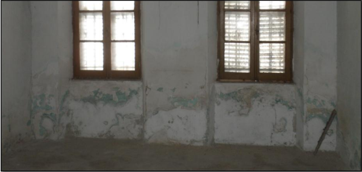
Εικόνα 53. Υγρασία ανερχόμενη από το έδαφος.
