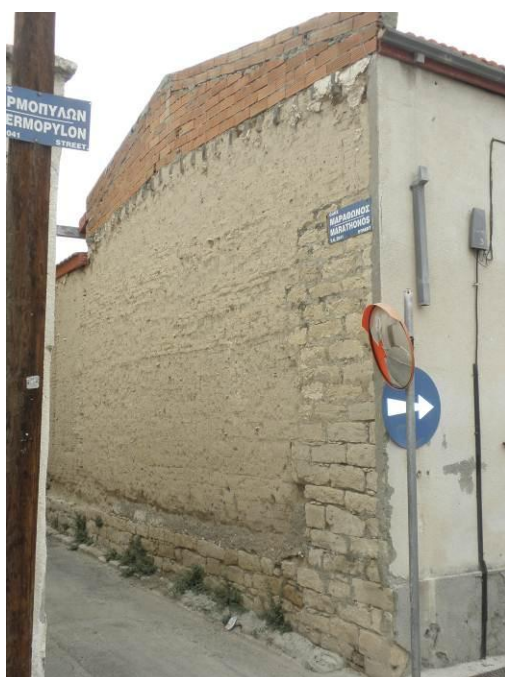
Εικόνα 3. Βορειοανατολική τοιχοποιία κτίσματος.
