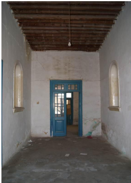
Εικόνα 9. Δωμάτιο 101 (πόρτιο) με αμφίπλευρα φατνώματα.
