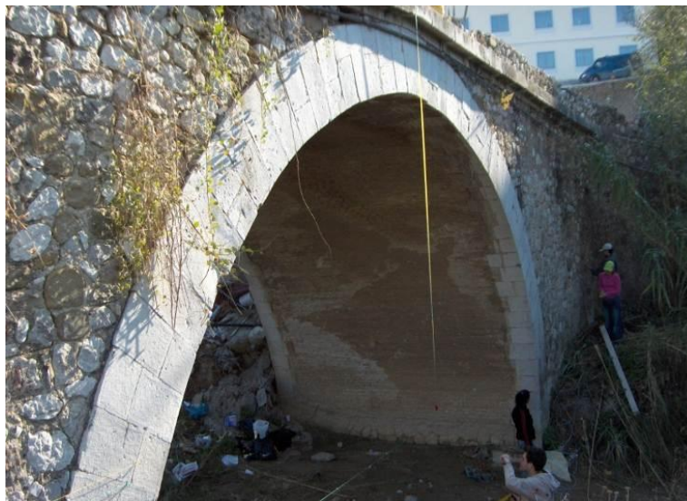
Εικόνα 1. Παράδειγμα αποτύπωσης ρωμαϊκής γέφυρας στην Πάτρα με την τοπομετρική μέθοδο, χρήση νήματος στάθμης και μετροταινίας. Πηγή: Προσωπικό αρχείο
