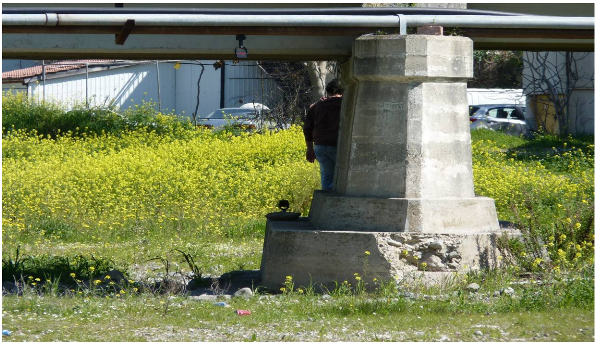
Εικόνα 8-6: Τοποθέτηση στόχων ώστε να περιληφθεί στην τρισδιάστατη σάρωση η γέφυρα.
