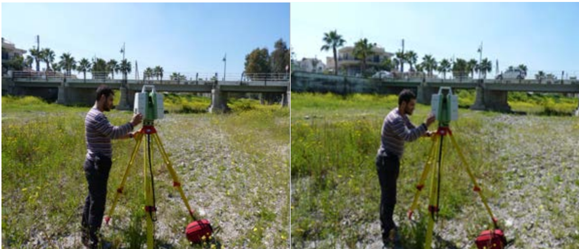
Εικόνα 5-1: Αποτύπωση κοίτης Γιαλιά πόταμου και γέφυρας με χρήση Laser Scanner Leica
