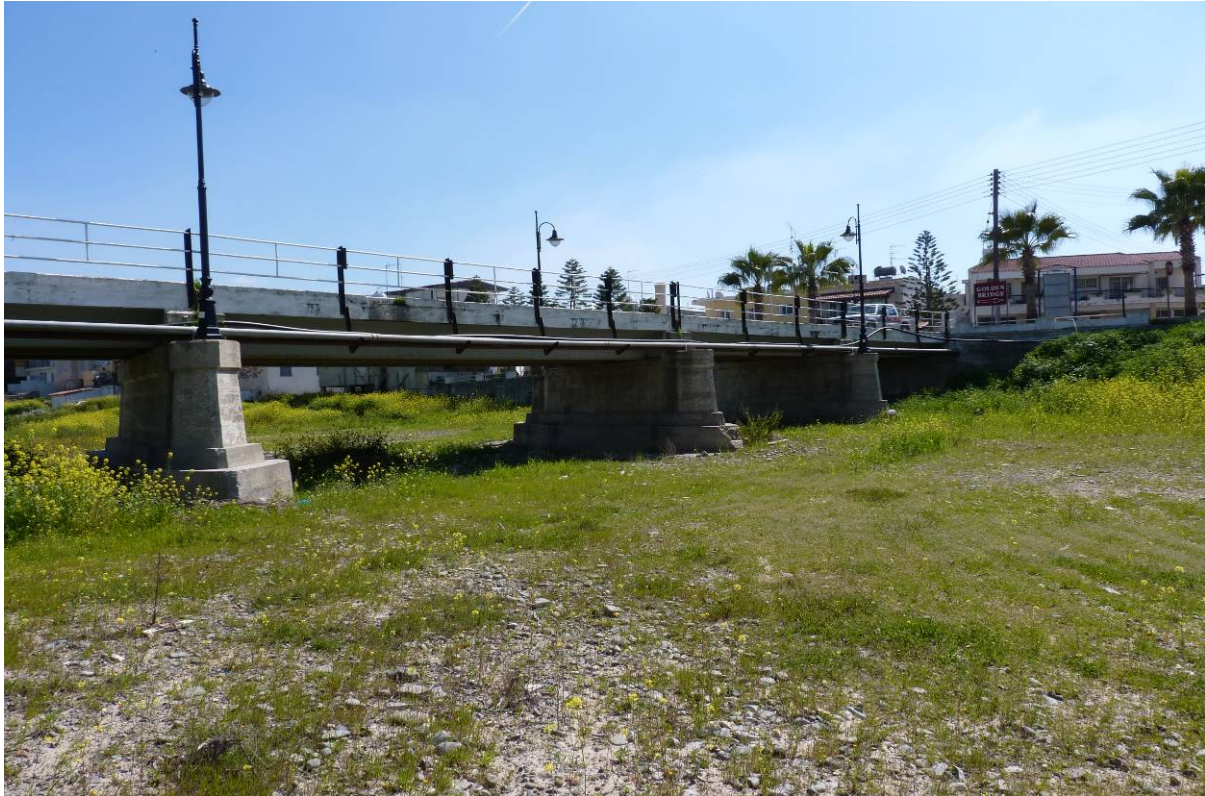
Εικόνα 8-3: Αποτύπωση γέφυρας για σκοπούς υδραυλικής προσομοίωσης του ερευνητικού προγράμματος "SATFLOOD"
