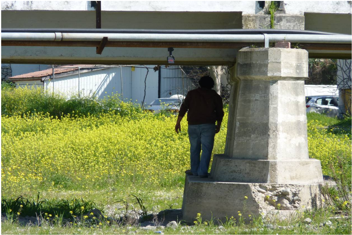
Εικόνα 8-5: Τοποθέτηση στόχων ώστε να περιληφθεί στην τρισδιάστατη σάρωση η γέφυρα.
