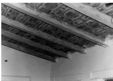
Εικόνα 16: Σύνθετο πάνελ οροφής με τούβλα
