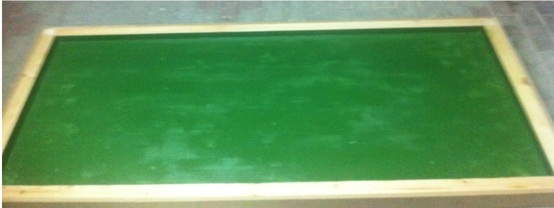
Σχήμα 4- 15: Μπογιατίσις απορροφητικής πλάκας με αστάρι
