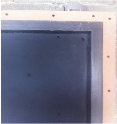
Σχήμα 4- 17: Τοποθέτηση αυτοκόλλητης ταινίας (Foum)
