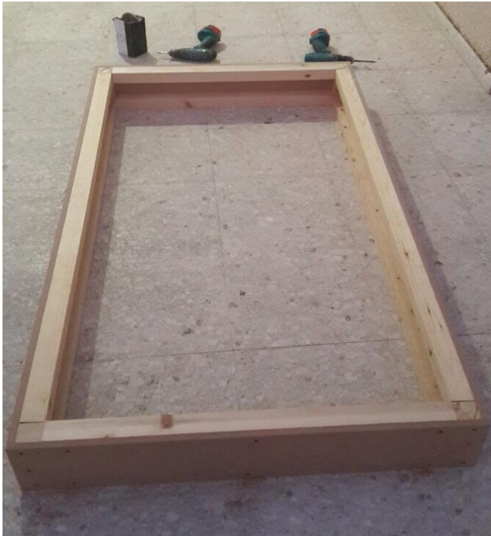
Σχήμα 4- 5: Κατασκευή ξύλινου πλαισίου
