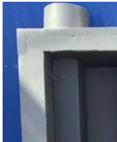
Σχήμα 4- 29: Τοποθέτηση αυτοκόλλητης ταινίας (Foum)
