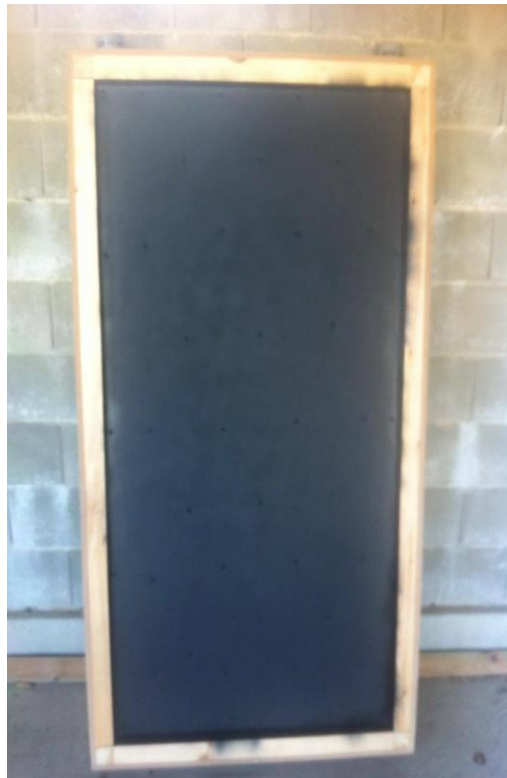
Σχήμα 4- 16: Μπογιατίσις απορροφητικής πλάκας με μαύρη Mad μπογιά
