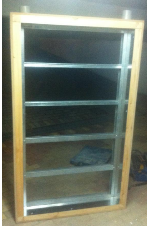
Σχήμα 4- 9: Σκελετός από μεταλλικά Π
