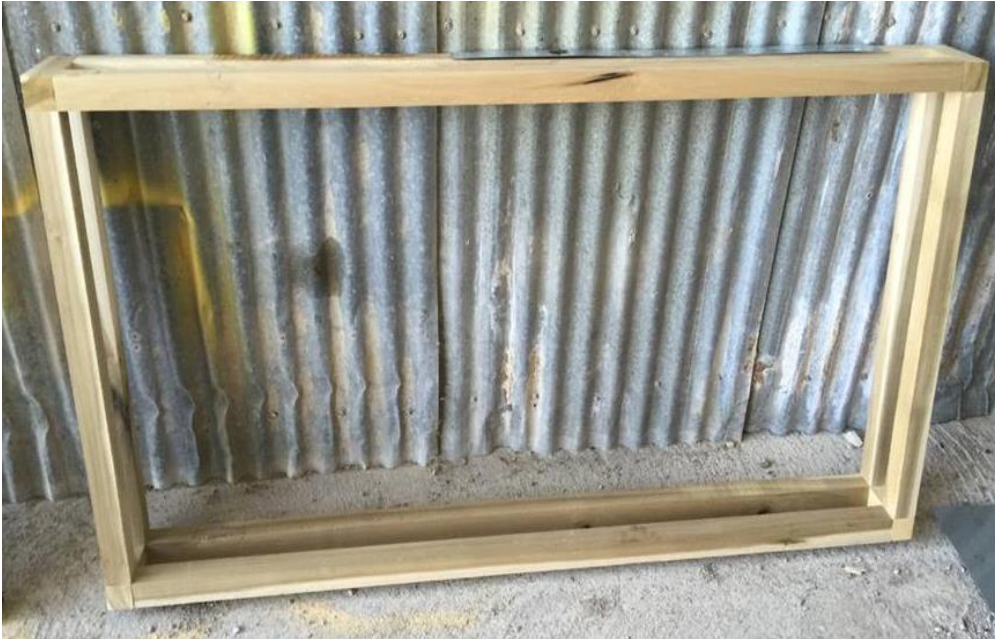
Σχήμα 4- 20: Κατασκευή ξύλινου πλαισίου
