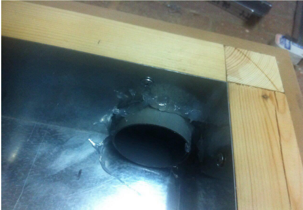
Σχήμα 4- 11: Τοποθέτηση λαμαρίνας και κοινής σιλικόνης
