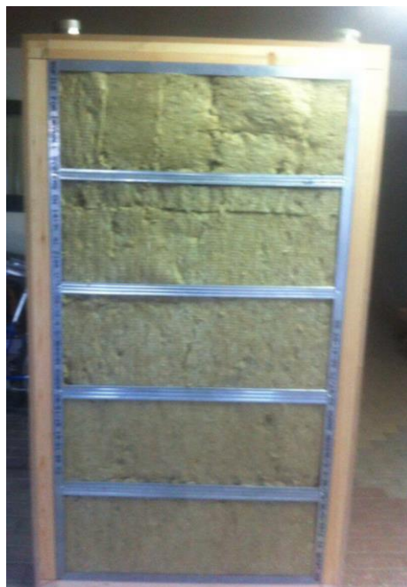
Σχήμα 4- 10: Τοποθέτηση πετροβάμβακα στο πίσω μέρος του συλλέκτη
