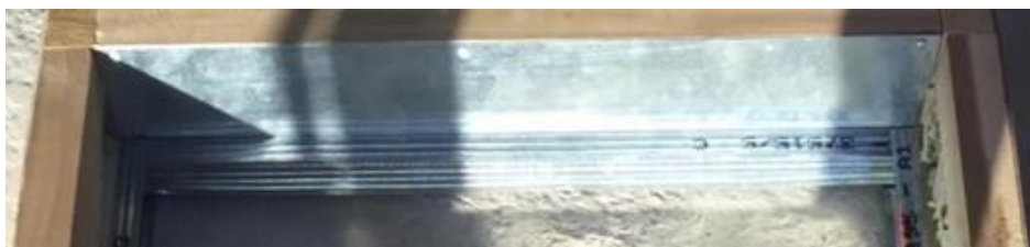
Σχήμα 4- 23: Τοποθέτηση γαλβανιζέ λαμαρίνας εσωτερικά του πλαισίου
