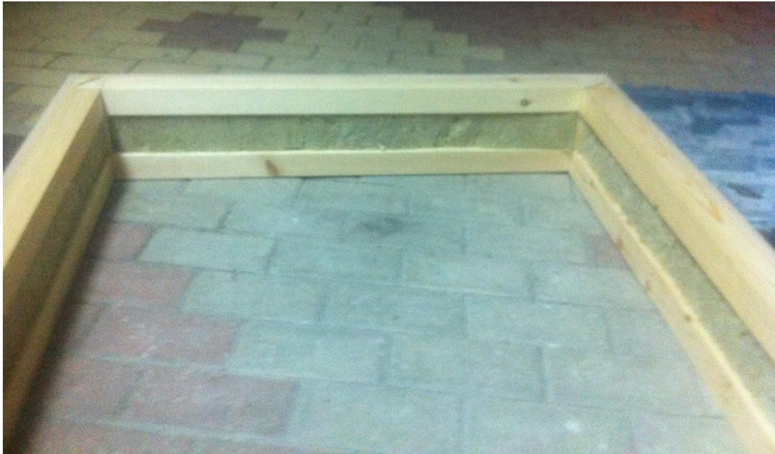
Σχήμα 4- 6: Τοποθέτηση πετροβάμβακα περιμετρικά του πλαισίου
