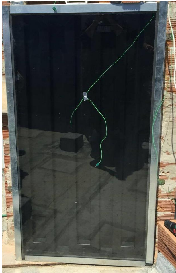
Σχήμα 4- 30: Τοποθέτηση υαλοπίνακα
