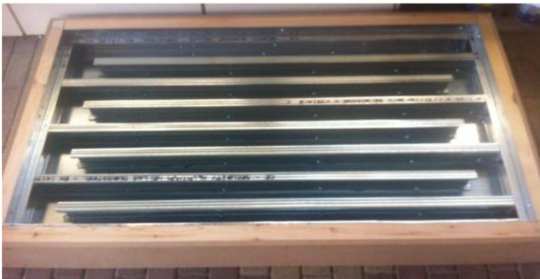
Σχήμα 4- 13: Τοποθέτηση διαχωριστικών μεταλλικών τοιχωμάτων τύπου Π
