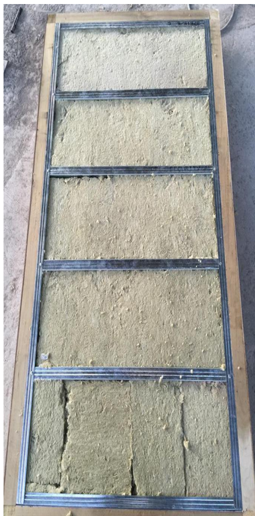
Σχήμα 4- 24: Τοποθέτηση πετροβάμβακα στο πίσω μέρος του συλλέκτη
