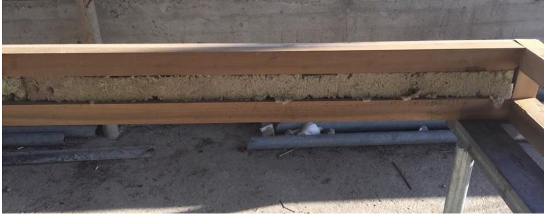
Σχήμα 4- 21: Τοποθέτηση πετροβάμβακα περιμετρικά του πλαισίου
