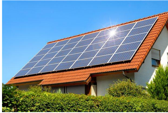
Εικόνα 1.12.1α: Φωτοβολταϊκά πλαίσια εγκατεστημένα σε κεκλιμένη στέγη
