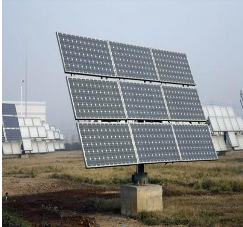
Εικόνα 1.12.3γ: Διαξονικό σύστημα πραγματικών διαστάσεων
