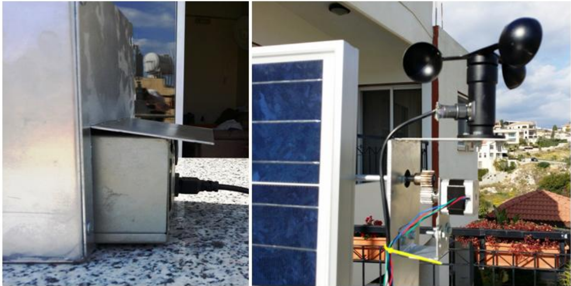
Εικόνα 5.2γ: Κατασκευή με φ/β πραγματικών διαστάσεων (3)
