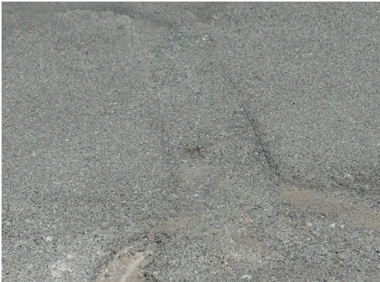
Εικόνα 5-5: Περιοχή πριν τα σάρωση με Γεωραντάρ
