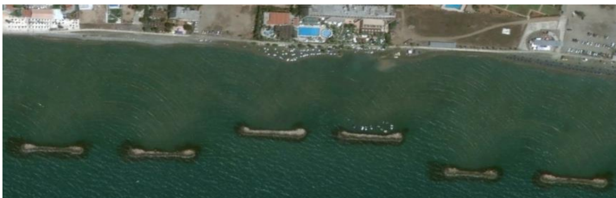
Εικόνα 11: Προσάμμιση ανάντη κυματοθραυστών (Ορόκλινη)
