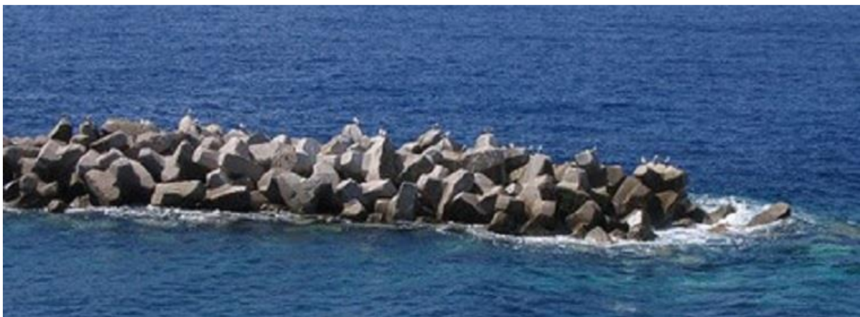
Εικόνα 9: Κυματοθραύστες από φυσικούς και τεχνητούς ογκολίθους.
