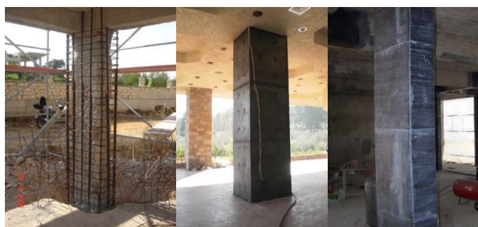
Σχήμα 1.7: (α) Περίσφιξη υποστυλώματος από μανδύα οπλισμένου σκυροδέματος.
