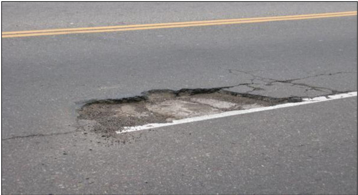
Σχήμα 1.6: Αποσύνθεση οδοστρώματος
