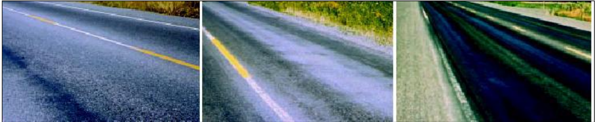
Σχήμα 2-2: Εφίδρωση Οδοστρωμάτων
