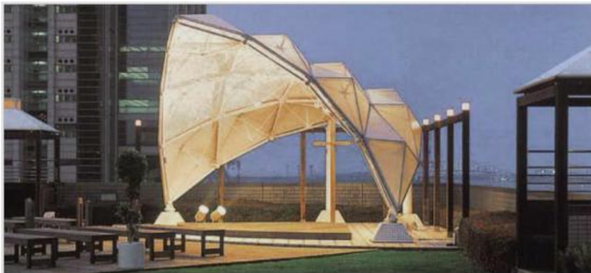
Σχήμα 35. Αυτή η δομή της μεμβράνης στο Hyatt Regency στην Οσάκα, χρησιμοποιεί μια φωτοκαταλυτική διαυγή επικάλυψη με βάση TiO_2 , η οποία δημιουργεί αντιβακτηριδιακή δράση. (Ashby et al., 2009) [1].
