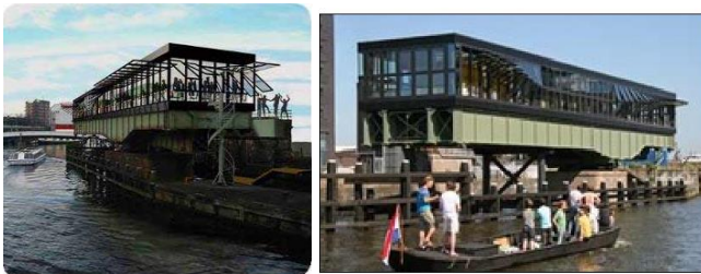
Διάγραμμα 20: Η μετατροπή σιδηροδρομικής γέφυρας στο Άμστερνταμ με ανακύκλωση χάλυβα, σε κέντρο αναψυχής.
