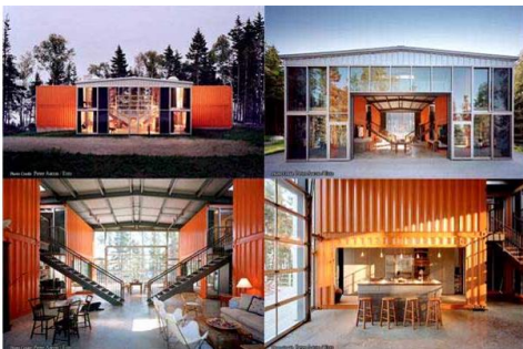
Διάγραμμα 47: Το 12-container house, το οποίο όπως λέει και το όνομα του είναι κατασκευασμένο από 12 containers.
