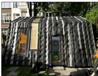
Διάγραμμα 12: Το προκατασκευασμένο ‘Tire House’ με τη χρήση ανακυκλωμένου γυαλιού και ελαστικών οχημάτων.
