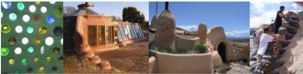
Διάγραμμα 38: «Γεώπλοιο», κατασκευασμένο από ελαστικά αυτοκινήτων, ανακυκλωμένο γυαλί και χώμα.
