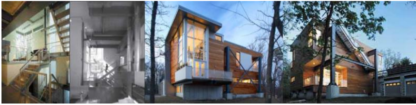
Διάγραμμα 19: Η κατοικία ‘Big Dig House’ που κατασκευάστηκε από ανακυκλωμένο χάλυβα, σκυρόδεμα, γυαλί και ξύλο.
