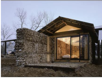
Διάγραμμα 35: Η κατοικία ‘Corrugated Cardboard Pod’ κατασκευασμένη από RDF.
