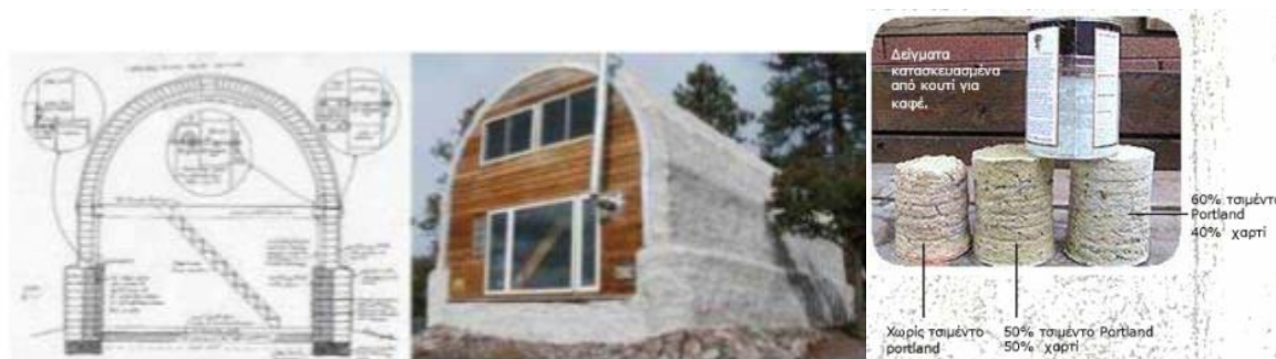
Διάγραμμα 28: Το κτίριο ‘Carriage House’ κατασκευασμένο από ‘Papercrete’.
