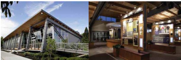
Διάγραμμα 51: Το περίπτερο που σχεδιάστηκε με σκοπό τη μελλοντική εύκολη αποσυναρμολόγηση, μεταφορά και επανασυναρμολόγηση.
