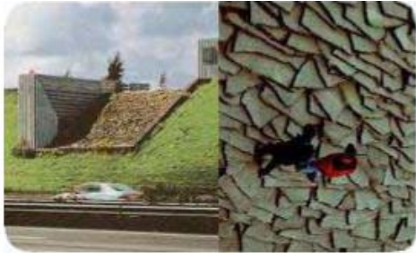
Διάγραμμα 15: Τοποθέτηση ανακυκλωμένης ασφάλτου για τη στήριξη πρανούς.
