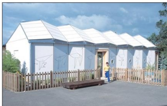
Διάγραμμα 34: Η αίθουσα διδασκαλίας ‘cutting – edge cardboard house’ κατασκευασμένη από φύλλα χαρτονιού.
