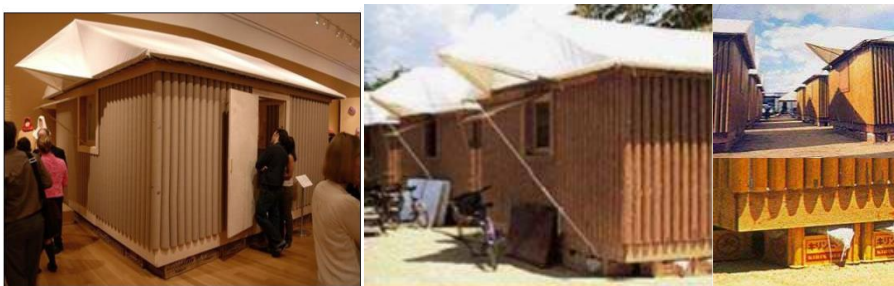
Διάγραμμα 30: Οικία Στέγασης των Σεισμόπληκτων του Kobe στην Ιαπωνία, κατασκευασμένη από κυλίνδρους πεπεισμένου χαρτονιού.
