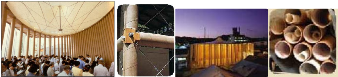
Διάγραμμα 32: Η εκκλησία του Shigeru Ban στο Kobe της Ιαπωνίας κατασκευασμένη από κυλίνδρους χαρτονιού.
