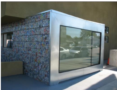
Διάγραμμα 22: Κατοικία με τη χρήση συμπιεσμένων κουτιών αλουμινίου 'Crushed Cans Building'.
