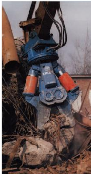
Εικόνα 1.3 Θρυμματιστής σκυροδέματος – «Ψαλίδι» - Concrete Cruncher
