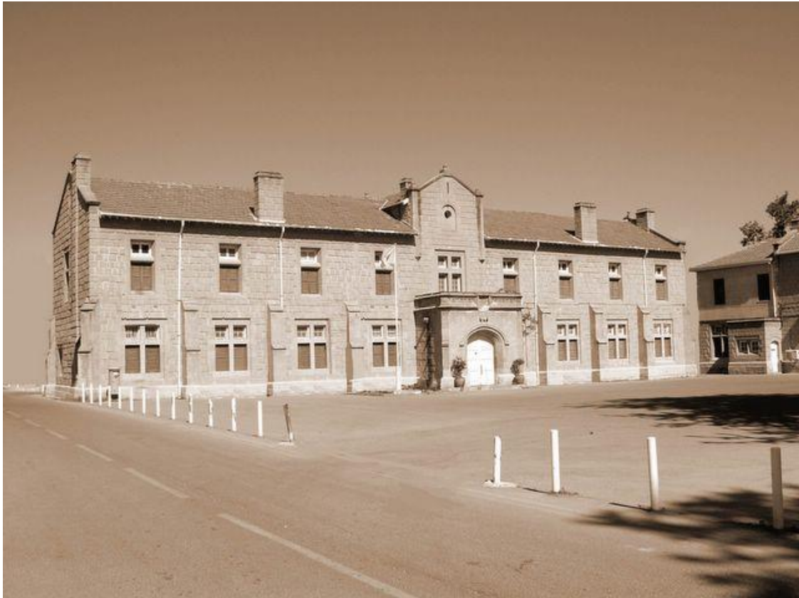
Εικόνα 10: Επαρχιακό Δικαστήριο Λευκωσίας
