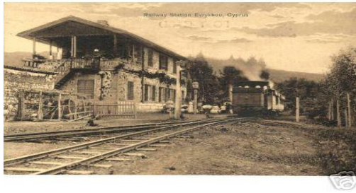
Εικόνα 9: Ευρύχου, Evrykhou railway station
