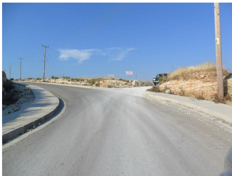
Φωτογραφία 2: Ο εγγεγραμμένος ασφαλτοστρωμένος δρόμος στα δυτικά του έργου.
