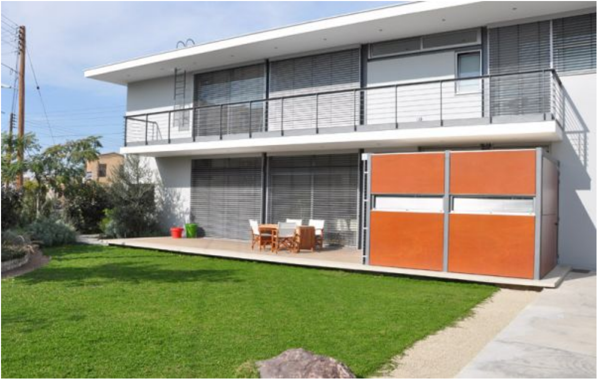
Εικόνα 4.4.15: Νότια όψη κατοικίας και εσωτερική αυλή
