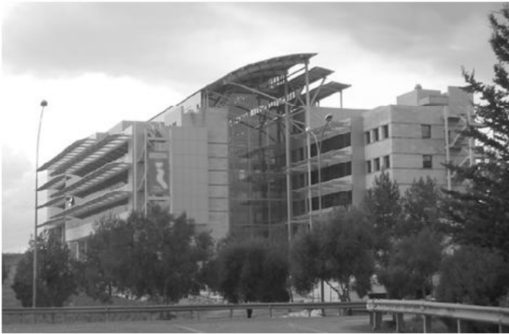
Εικόνα 1.19: Κτίριο διοίκησης της Αρχής Ηλεκτρισμού Κύπρου στη Λευκωσία [32]
