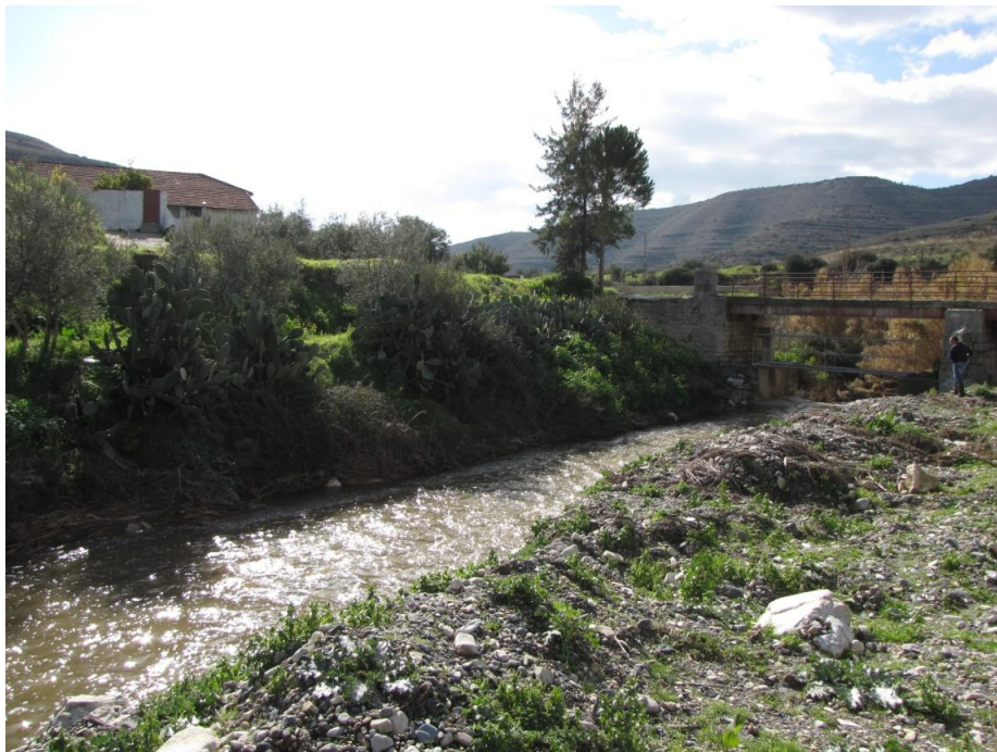
Εικόνα Π.21: Θέση S4, έντονη ροή μετά από βροχοπτώσεις Ιαν.2012.
