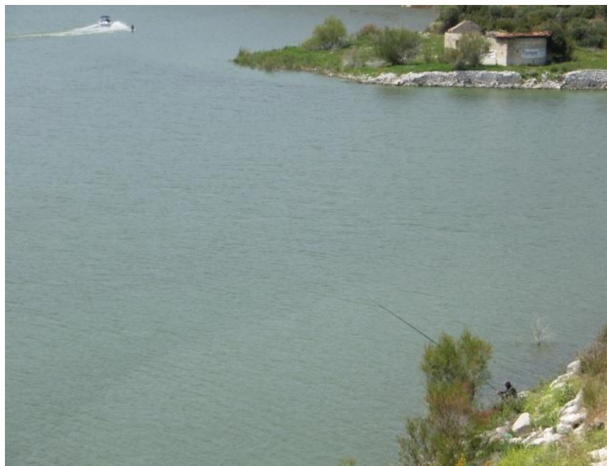
Εικόνα Π.32: Θέση S6, ΒΑ είσοδος του φράγματος των Πολεμιδιών
