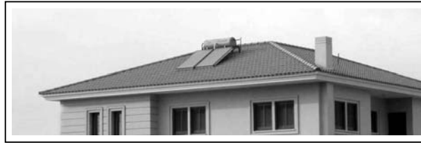
Εικόνα 3: Ηλιακός θερμοσίφωνας με πιεστικό σύστημα νερού
