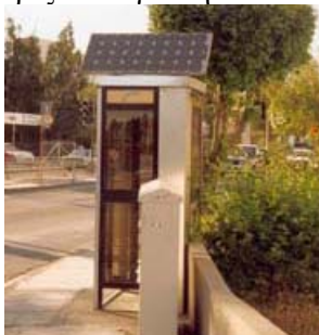
Εικόνα 8: Τηλεφωνικός θάλαμος που τροφοδοτείται από φωτοβολταϊκό σύστημα
