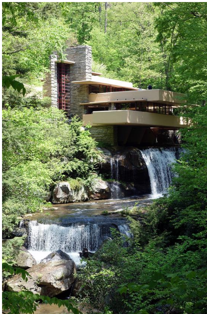
Εικόνα. 19. Frank Lloyd Wright, Fallingwater , 1936 - 1939, ενισχυμένο μπετόν, πέτρα και ατσάλι, Mill Run, Pennsylvania, Η.Π.Α.
