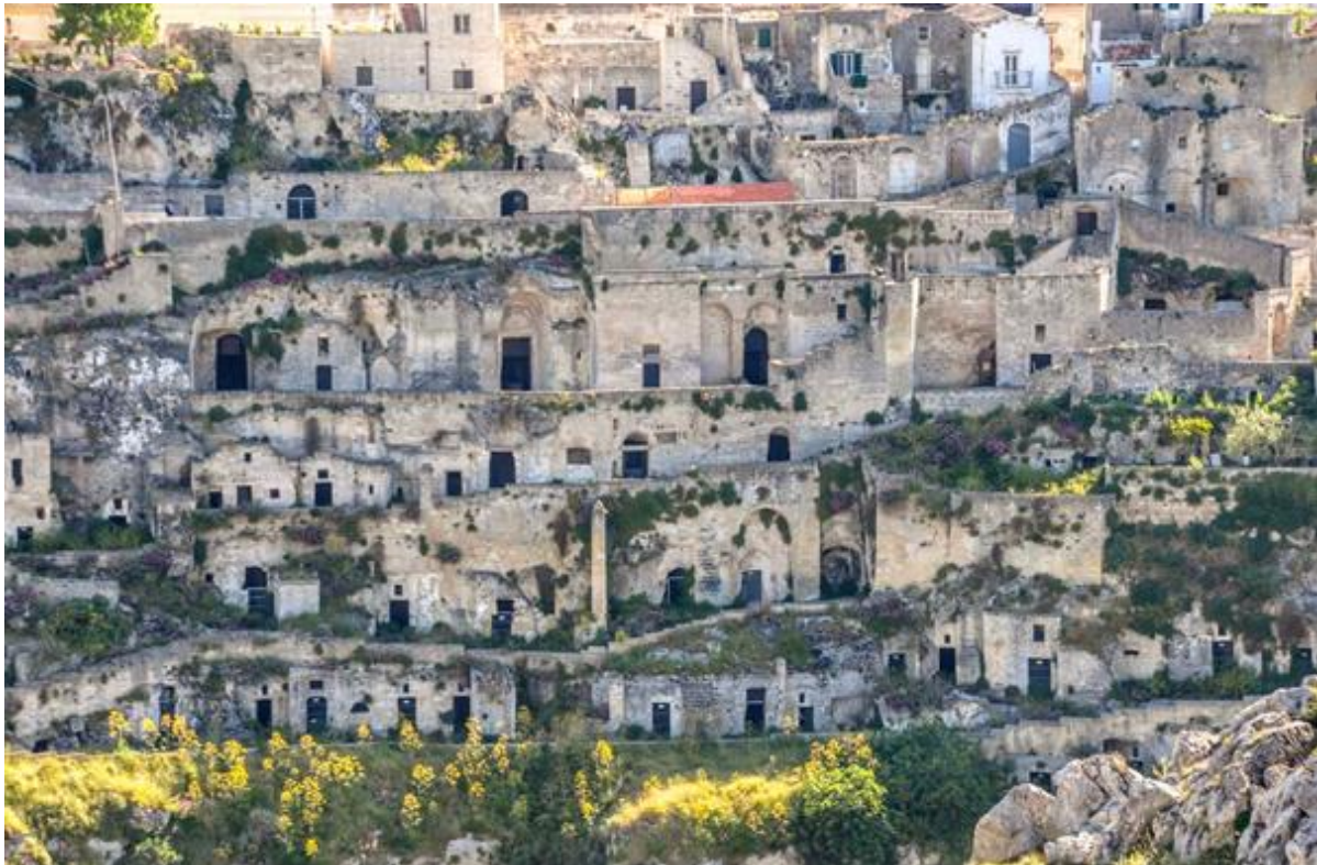
Εικόνα. 18. Λαϊκή (Vernacular) αρχιτεκτονική, Sassi di Matera, Ιταλία.
