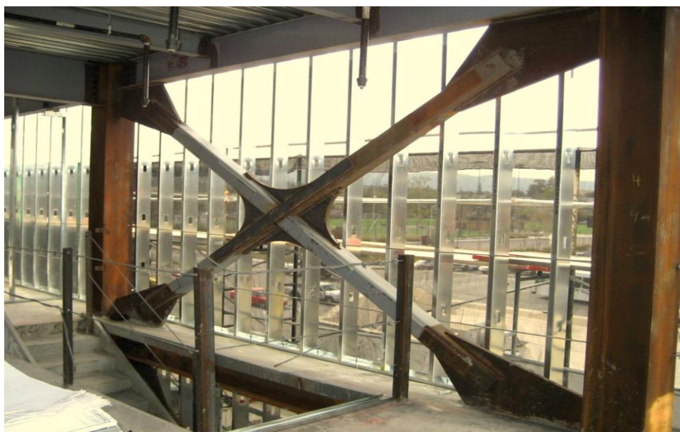
Εικόνα 1.1: Λεπτομέρειες διάταξης διαγώνιων μελών Χ διαμόρφωσης (Πηγή: https://gr.Pinterest.com/pin/377317275000461611/?autologin=true )
