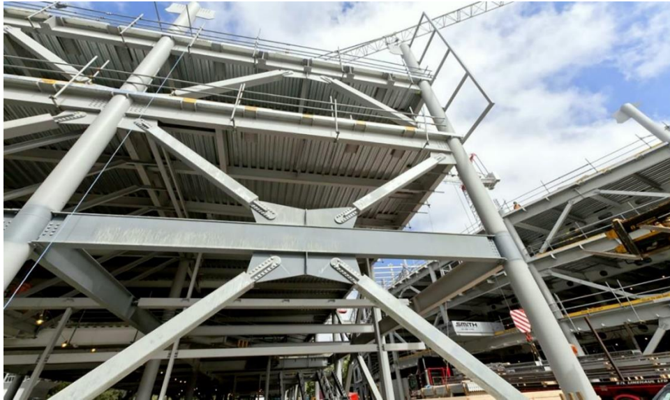
Εικόνα 2.2: Λεπτομέρειες διάταξης διαγώνιων μελών V, Λ διαμόρφωσης (Πηγή: https://www.hera.org.nz/brittle-fracture-update/ )
