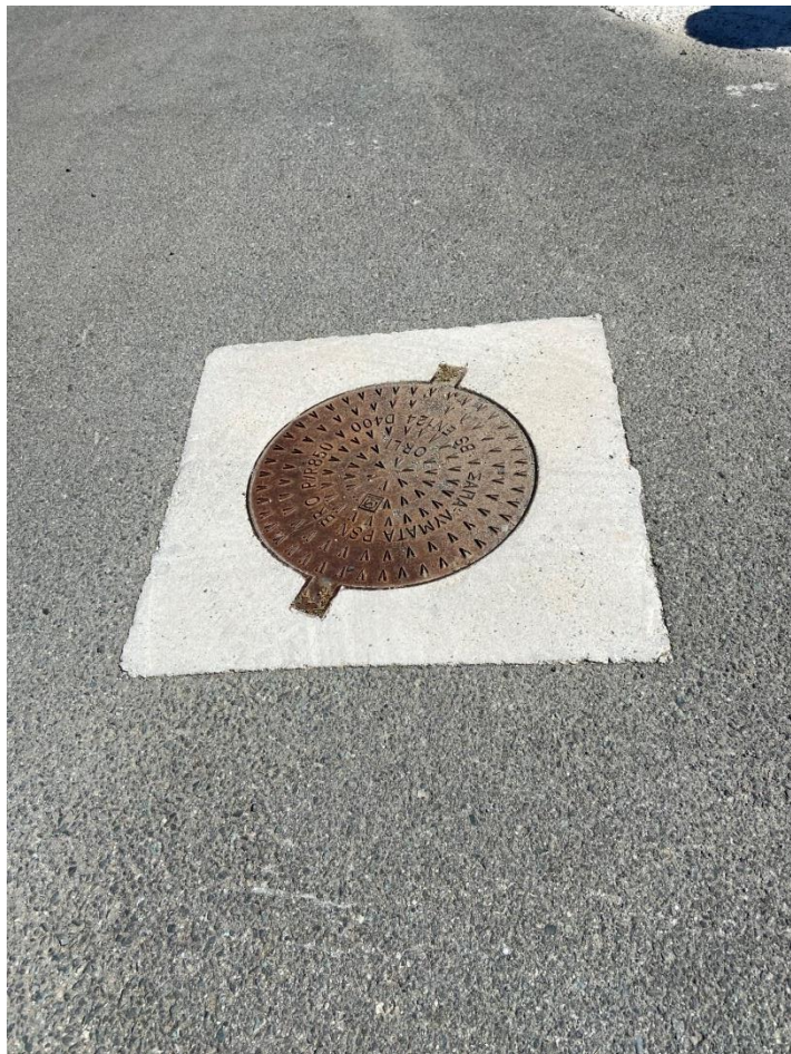
Διάγραμμα 25: Φρέατιο σε οδόστρωμα από σκυρόδεμα και χάλυβα
