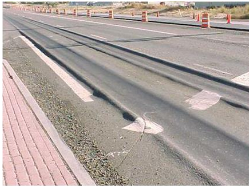
Διάγραμμα7:Rutting(Mettas et al.)
