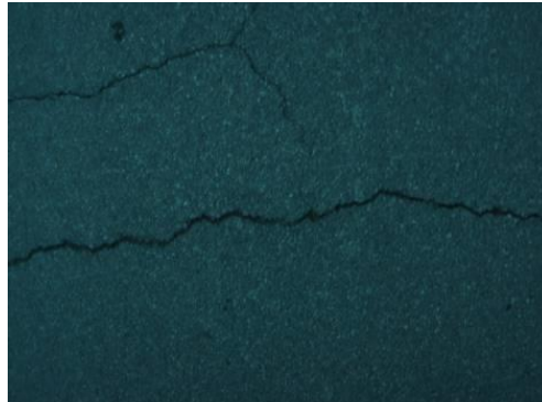
Διάγραμμα 1: Εγκάρσιες Ρωγμές σε οδόστρωμα(Naukowe et al.)
