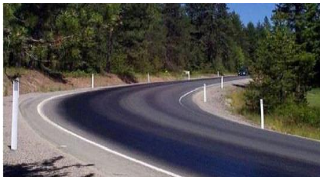
Διάγραμμα 12: Bleeding (Mettas et al.)
