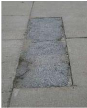
Διάγραμμα9: Patch Failures(Mettas et al.)
