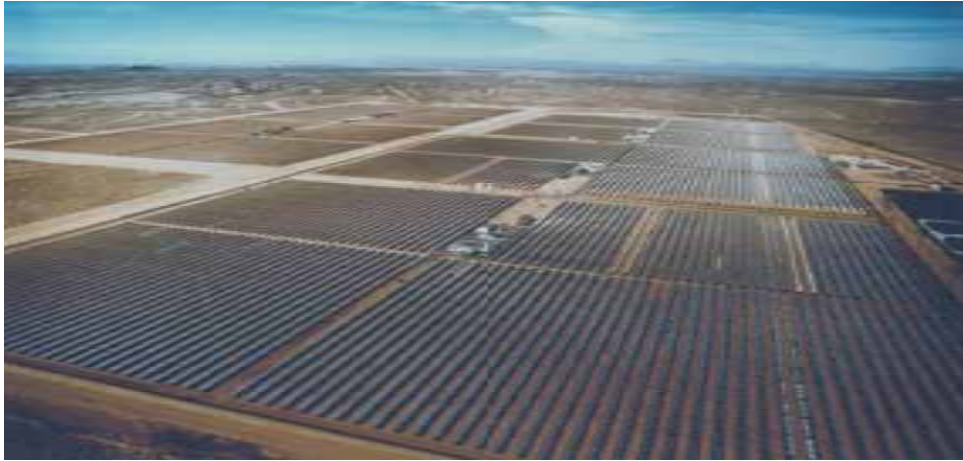
Εικόνα 1: Φωτογραφία ενός από τα εργοστάσια SEGS
