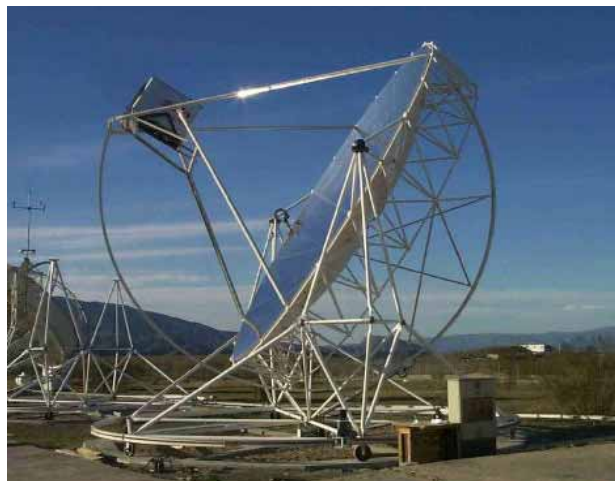
Εικόνα 3: Φωτογραφία του συστήματος σημειακής εστίασης που κατασκευάστηκε από Ευρωπαϊκές εταιρείες (Eurodish) με θερμική μηχανή τύπου Stirling
