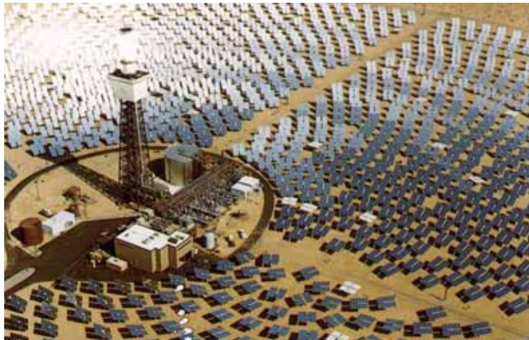
Εικόνα 2: Φωτογραφία του συστήματος Solar Two
