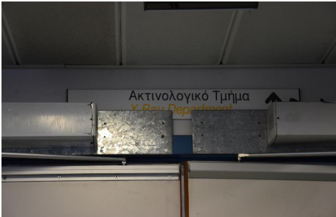
Εικόνα 5: Λανθασμένη τοποθέτηση πινακίδας
