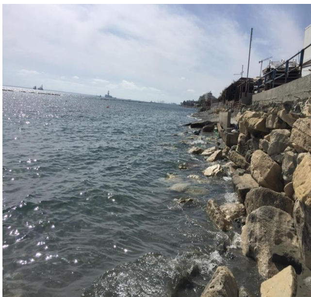
Διάγραμμα 9: Έντονη διάβρωση στο παραλιακό μέτωπο Ναυτικού Ομίλου Λεμεσού
