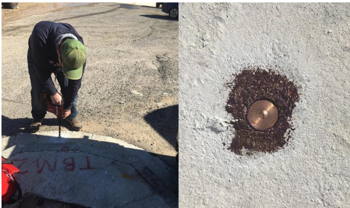
Διάγραμμα 13: Τοποθέτηση Μπουλονιών – Υψομετρικών Αφετηριών
