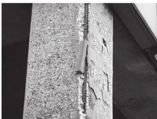
Διάγραμμα 3: Διάβρωση προκαλούμενη από χλωριόντα σε παραθαλάσσια κατασκευή (Grantham2011)
