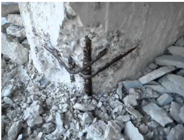
Διάγραμμα 1: Διάβρωση χάλυβα οπλισμένου σκυροδέματος (Επιδόμος χ.χ.)
