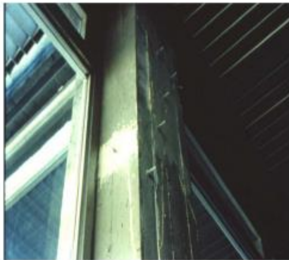
Διάγραμμα 59: Επισκευή υποστυλώματος με ρητινενέσεις (Δρίτσος 2014)
