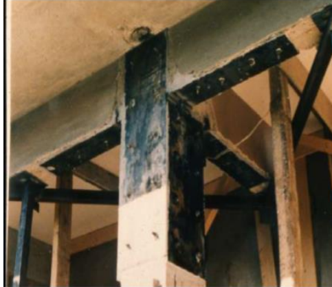
Διάγραμμα 85: Ενίσχυση κόμβου με επικολλητά χαλύβδινα ελάσματα (Δρίτσος 2014)
