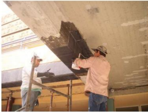
Διάγραμμα 112: Διατμητική ενίσχυση δοκού με ινοπλισμένα πολυμερή (Παναγόπουλος χ.χ)
