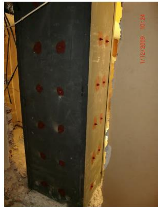
Διάγραμμα 75: Ενίσχυση υποστύλωματος με μεταλλικό μανδύα (Σιδέρης χ.χ)
