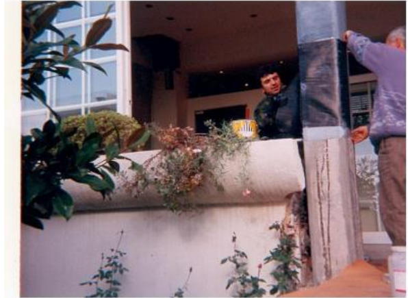
Διάγραμμα 70: Περίσφιξη υποστρώματος με ινοπλισμένα πολυμερή της μορφής ταινιών «πακεταρίσματος» (Δρίτσος 2014)
