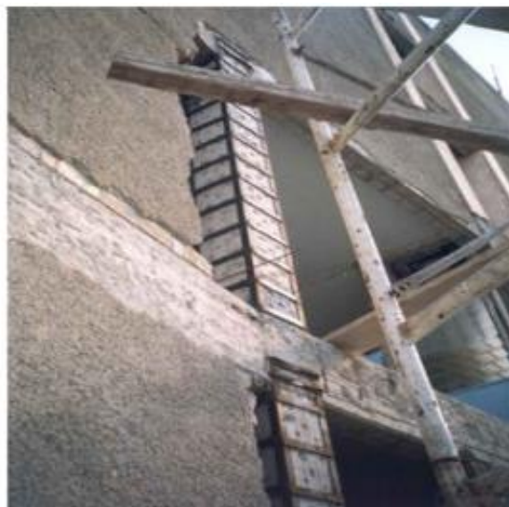
Διάγραμμα 48: Εφαρμογή μεταλλικών ελασμάτων (cited in Αγγέλη και Σταματοπούλου 2011)
