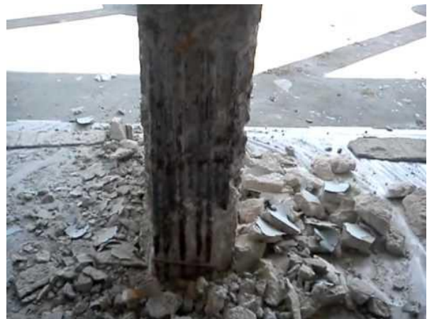
Διάγραμμα 1: Διάβρωση χάλυβα οπλισμένου σκυροδέματος (Επιδόμος χ.χ.)
