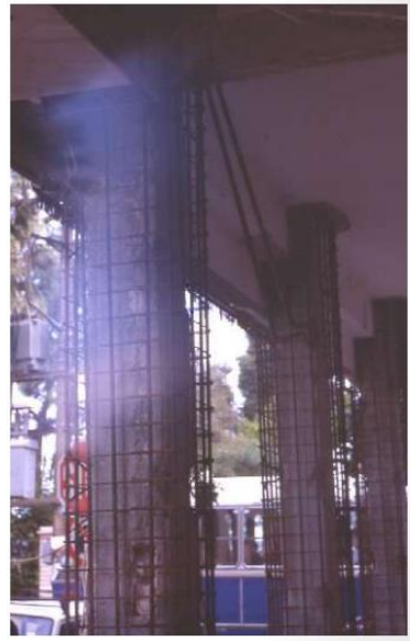
Διάγραμμα 66: Ενίσχυση υποστυλώματος με μανδύα σπλισμένου σκυροδέματος (Δρίτσος 2014)
