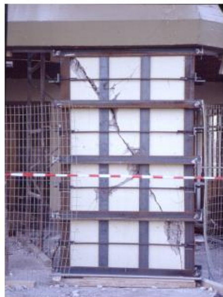
Διάγραμμα 92: Ενίσχυση τοιχώματος με μεταλλικό κλωβό
