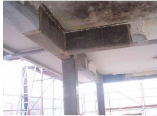
Διάγραμμα 112: Διατμητική ενίσχυση δοκού με ινοπλισμένα πολυμερή (Παναγόπουλος χ.χ)
