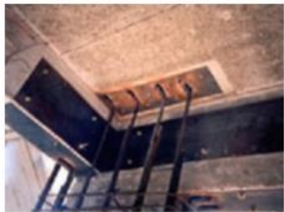
Διάγραμμα 108: Ενίσχυση δοκού με χαλύβδινα ελάσματα (Δρίτσος 2014)
