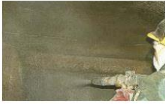
Διάγραμμα 56: Εφαρμογή προστατευτικών επιστρωμάτων στο σκυροδέμα (Τσίκας & Παπασπυριδάκος χ.χ.)
