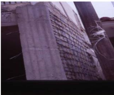
Διάγραμμα 91: Ενίσχυση τοιχώματος με μανδύα οπλισμένου σκυροδέματος (Δρίτσος 2014)
