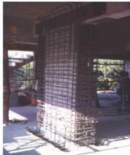
Διάγραμμα 91: Ενίσχυση τοιχώματος με μανδύα οπλισμένου σκυροδέματος (Δρίτσος 2014)
