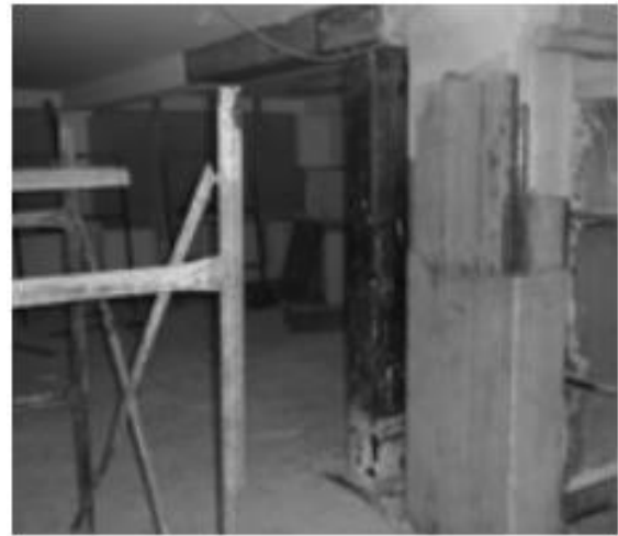
Διάγραμμα 102: Μείωση του ανοίγματος δοκού με χρήση μεταλλικού υποστυλώματος (Σπυράκος 2004)
