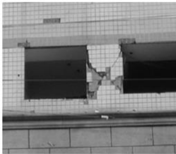
Διάγραμμα 9: Διατμητικού χαρακτήρα βλάβη σε υποστύλωμα (cited in Καΐρης & Χατζηβασιλειάδης 2008)
