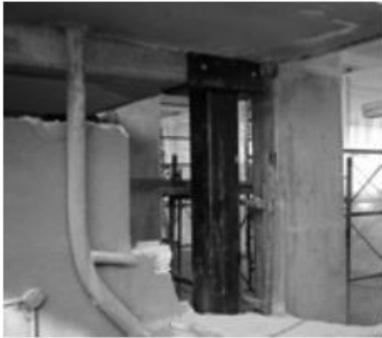
Διάγραμμα 102: Μείωση του ανοίγματος δοκού με χρήση μεταλλικού υποστυλώματος (Σπυράκος 2004)
