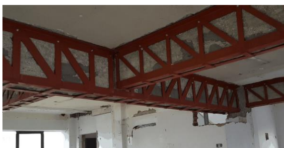
Διάγραμμα 105: Ενίσχυση δοκού με μεταλλικές λάμες (Κκολός 2018)
