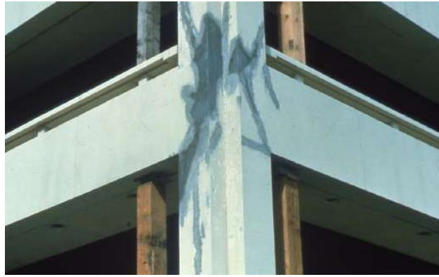
Διάγραμμα 79: Επισκευή κόμβου Δοκού-Υποστυλώματος (Δρίτσος 2014)
