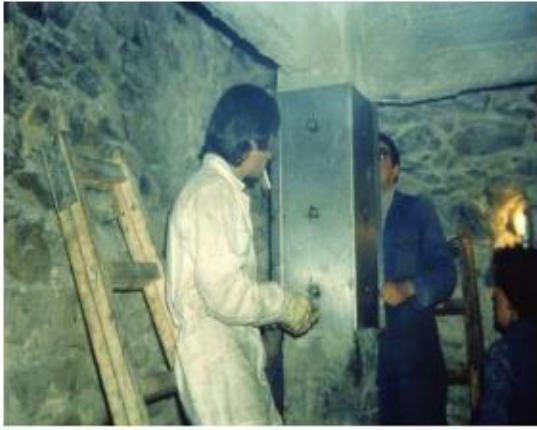
Διάγραμμα 69: Περίσφιξη υποστρώματος με χαλύβδινα ελάσματα (Δρίτσος 2014)
