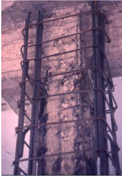
Διάγραμμα 66: Ενίσχυση υποστυλώματος με μανδύα σπλισμένου σκυροδέματος (Δρίτσος 2014)
