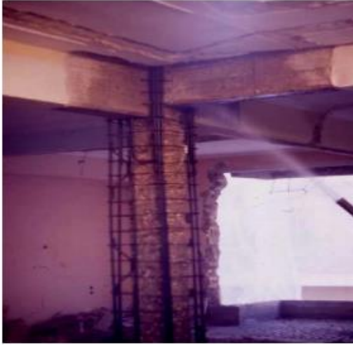
Διάγραμμα 55: Ενίσχυση υποστυλώματος με μανδύα οπλισμένου σκυροδέματος (Δρίτσος 2014)
