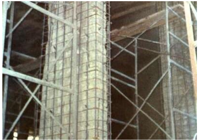
Διάγραμμα 55: Ενίσχυση υποστυλώματος με μανδύα οπλισμένου σκυροδέματος (Δρίτσος 2014)
