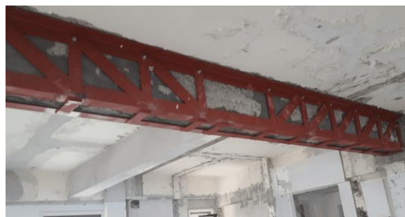
Διάγραμμα 105: Ενίσχυση δοκού με μεταλλικές λάμες (Κκολός 2018)
