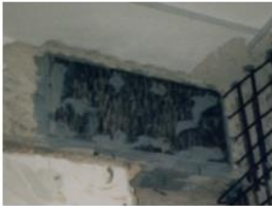
Διάγραμμα 108: Ενίσχυση δοκού με χαλύβδινα ελάσματα (Δρίτσος 2014)
