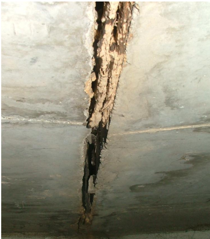
Εικόνα 19: Η κατασκευή αρχίζει να υποχωρεί. Το γεφύρι έχει χάσει την φέρουσα ικανότητα του και δεν μπορεί να κατανέμει τα φορτία για τα οποία έχει σχεδιαστεί.
