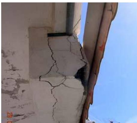
Εικόνα 6: Ρηγμάτωση παράλληλα στους οπλισμούς:
