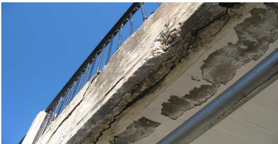
Εικόνα 2: Ομοιόμορφη διάβρωση
