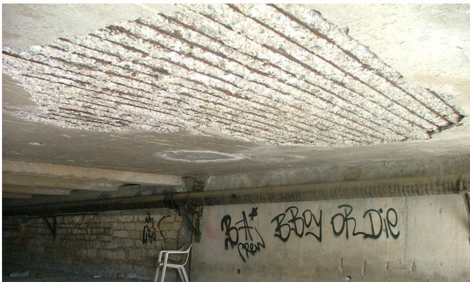
Εικόνα 11: Γεφύρι Holliday Inn Limassol
