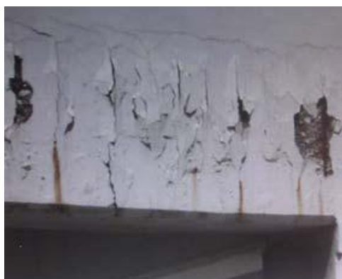
Εικόνα 7: Αποφλοιώση σκυροδέματος:
