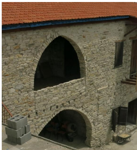
Εικόνα 43: Βαριά θολωτά πατώματα σε πέτρινη οικοδομή
