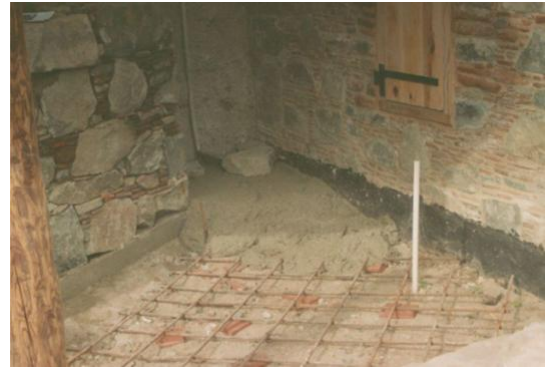
Εικόνα 36: Κατασκευή πατώματος από οπλισμένο σκυρόδεμα
