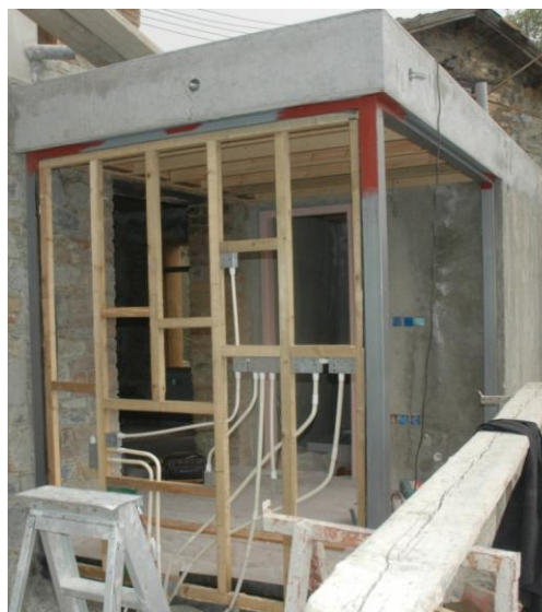
Εικόνα 84: Τοποθέτηση ξύλινου σκελετού
