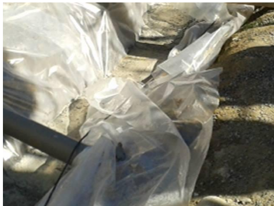
Εικόνα 116: Φύλλο πολυθίνης και στρώση από μπετόν
