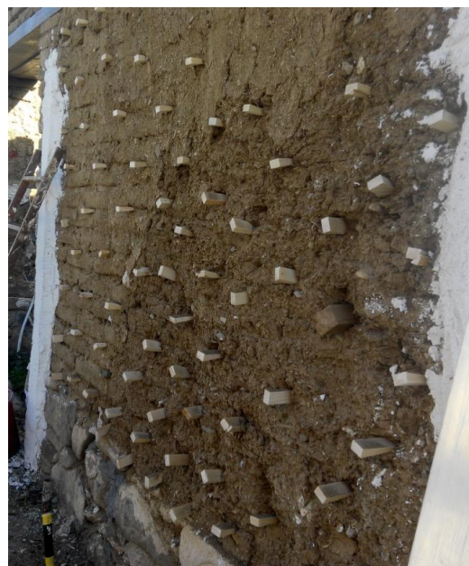
Εικόνα 113: Τοποθέτηση ξύλινων σφηνών
