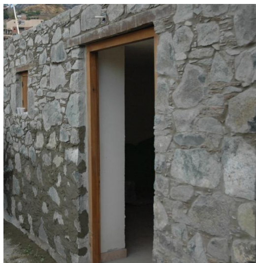
Εικόνα 92: Αρμολόγημα σε τοίχο οικοδομής
