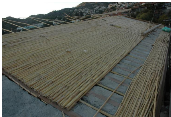
Εικόνα 26: Επικάλυψη οροφής με καλάμια
