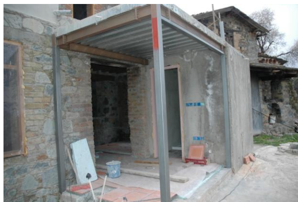
Εικόνα 82: Κτίσιμο βοηθητικού χώρου
