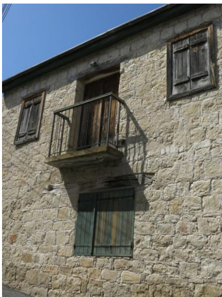
Εικόνα 9: Λαξευτή πέτρινη τοιχοποιία
