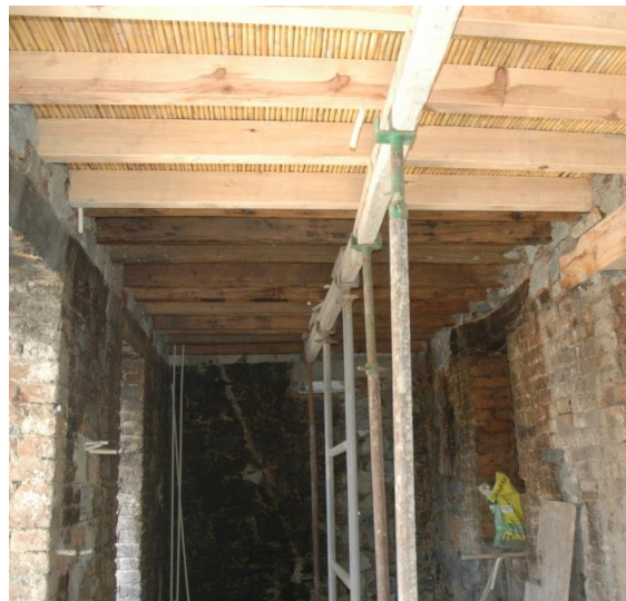
Εικόνα 76: Υποστύλωση πλάκας υπογείου
