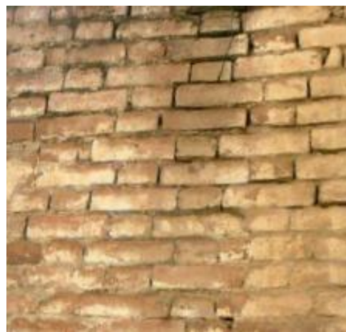
Εικόνα 12: Οπτοπλινθοδομή με φθορές
