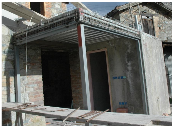
Εικόνα 83: Τοποθέτηση δικτυωτού πλέγματος
