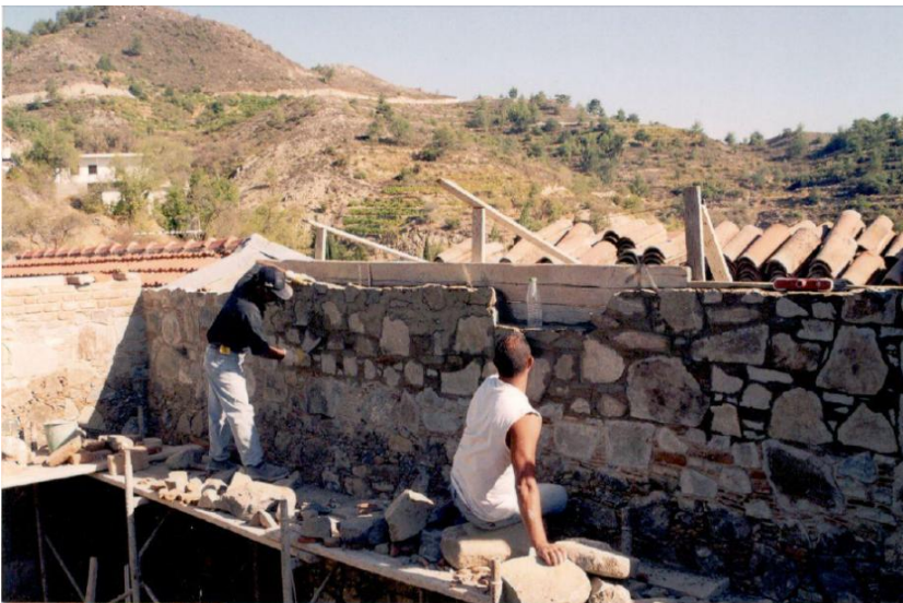
Εικόνα 3: Χτίσιμο πέτρινης τοιχοποιίας
