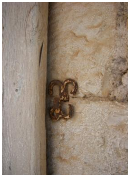
Εικόνα 75 : Μεταλλικά τζινέτια σφηνωμένα ανάμεσα σε λίθους
