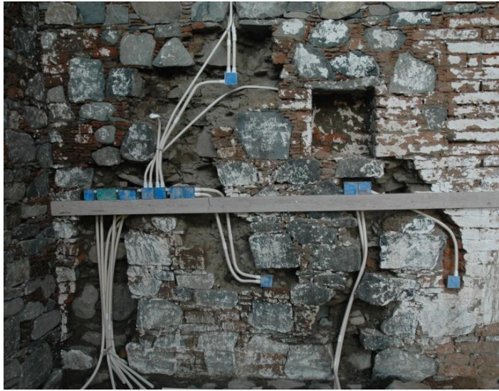
Εικόνα 72: Τοποθέτηση υπηρεσιών πριν το χαλίκωμα
