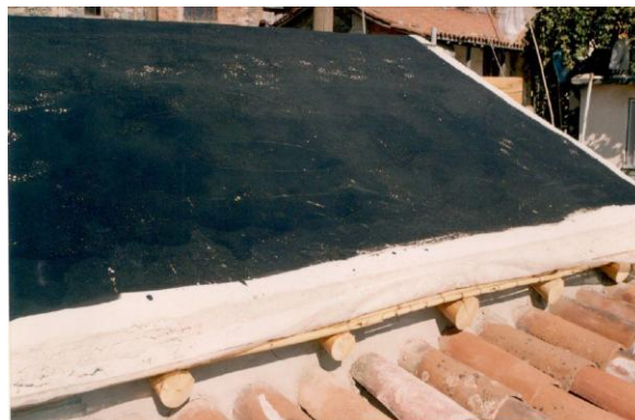
Εικόνα 32: Τοποθέτηση κατρόχαρτου για απομόνωση
