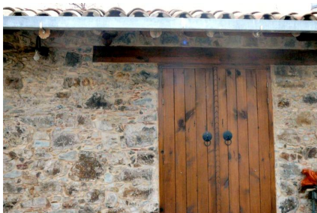
Εικόνα 51: Κούφωμα μετά την αποκατάσταση
