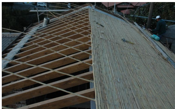
Εικόνα 25: Τοποθέτηση καλαμιών
