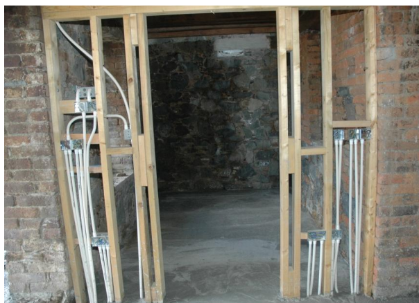
Εικόνα 77: Κατασκευή ξύλινου διαχωριστικού
