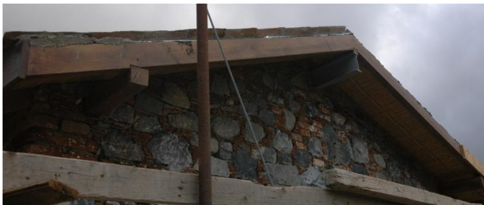
Εικόνα 30: Μορφή στέγης μετά την αποκατάσταση
