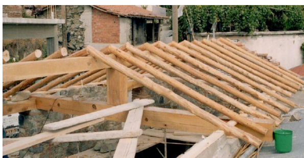
Εικόνα 33: Αποκατάσταση στέγης με καλάμια
