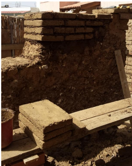
Εικόνα 114: Κατασκευή τοίχου από πλινθάρι
