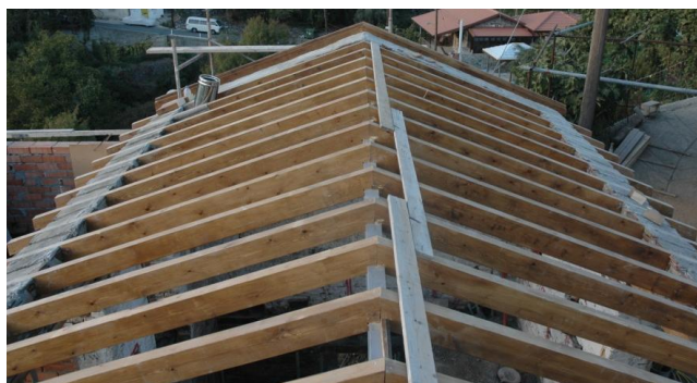
Εικόνα 23: Κατασκευή ξύλινων δοκών
