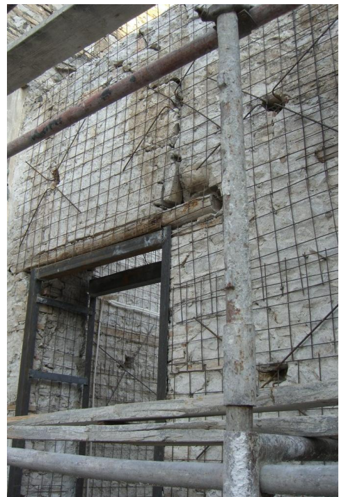
Εικόνα 100: Τοποθέτηση οπλισμού και αγκύρωση μέσα στην τοιχοποιία
