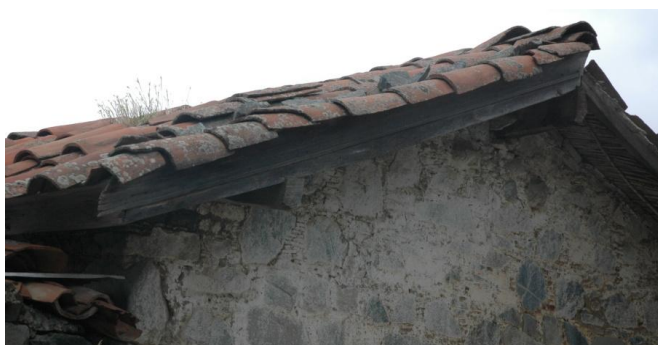
Εικόνα 20: Μορφή στέγης εξωτερικά
