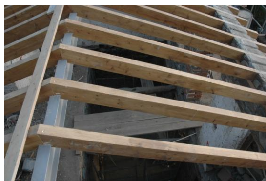
Εικόνα 24: Έδραση δοκών στον κορφιά
