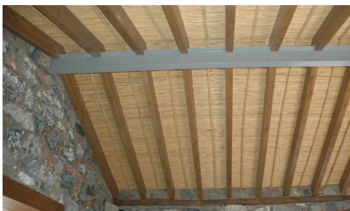
Εικόνα 28: Αποκατάσταση οροφής με βολίτζια, καλάμια και μεταλλική δοκό
