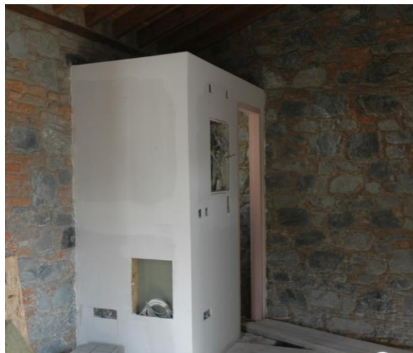
Εικόνα 80: Κατασκευή βοηθητικού χώρου
