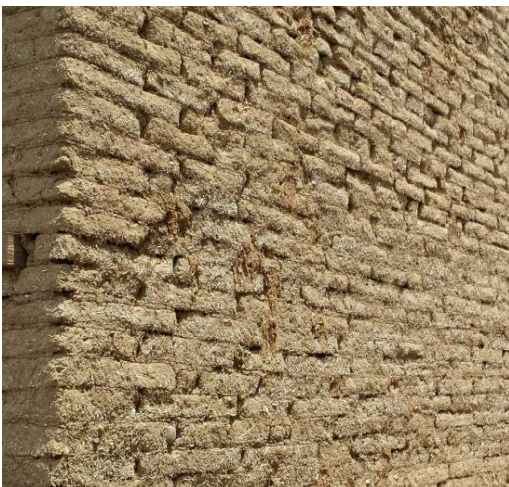
Εικόνα 110: Πλίνθινη τοιχοποιία
