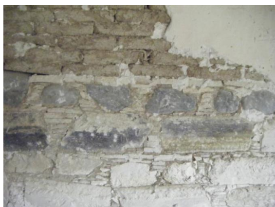
Εικόνα 1: Πλίνθινη τοιχοποιία, σειρά από πέτρες του ποταμού και στρώσεις από τοπικά ιζηματογενή πετρώματα
