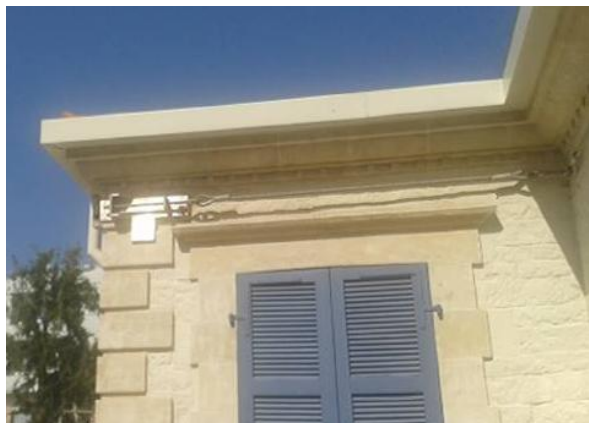
Εικόνα 102: Τένοντες εξωτερικά της οικοδομής
