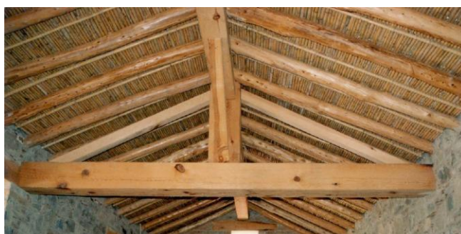
Εικόνα 34: Κατασκευή οροφής με βολιτζια
