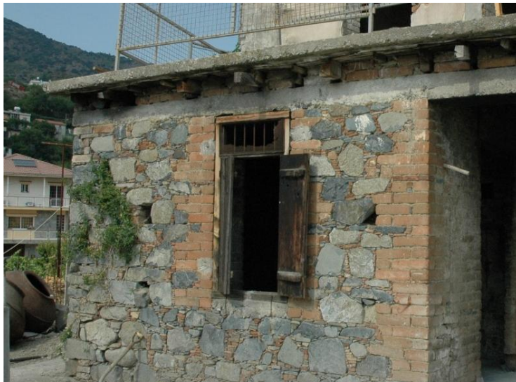
Εικόνα 96: Οικοδομή με οριζόντιο διάζωμα σκυροδέματος
