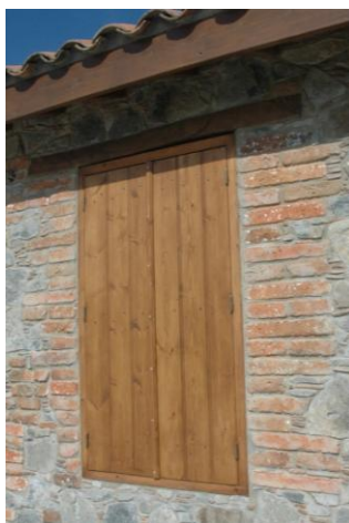
Εικόνα 53: Παράθυρο μετά την αποκατάσταση
