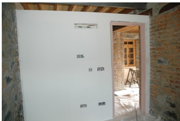
Εικόνα 79: Τοποθέτηση γυψοσανίδας
