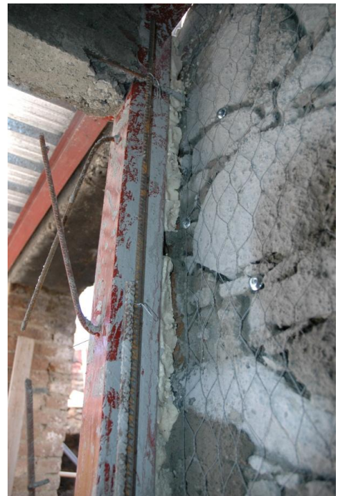
Εικόνα 109: Τοποθέτηση γαλβανισμένου πλέγματος
