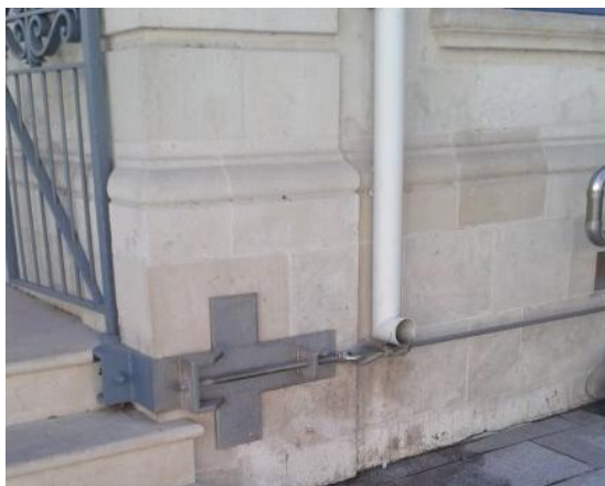
Εικόνα 106: Τένοντας στην γωνιά της τοιχοποιίας
