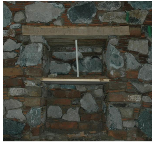
Εικόνα 64: Αποκατάσταση κουφώματος
