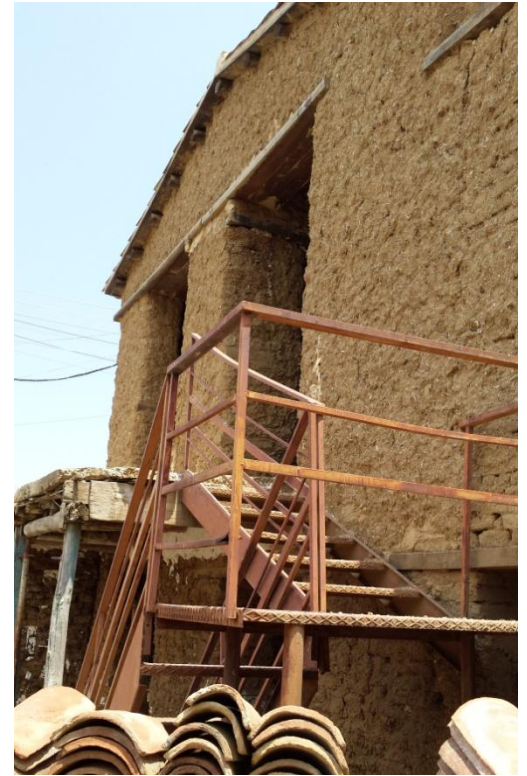
Εικόνα 122: Υφιστάμενη όψη κατοικίας
