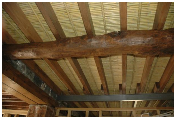
Εικόνα 41: Μεταγενέστερη αποκατάσταση πατώματος
