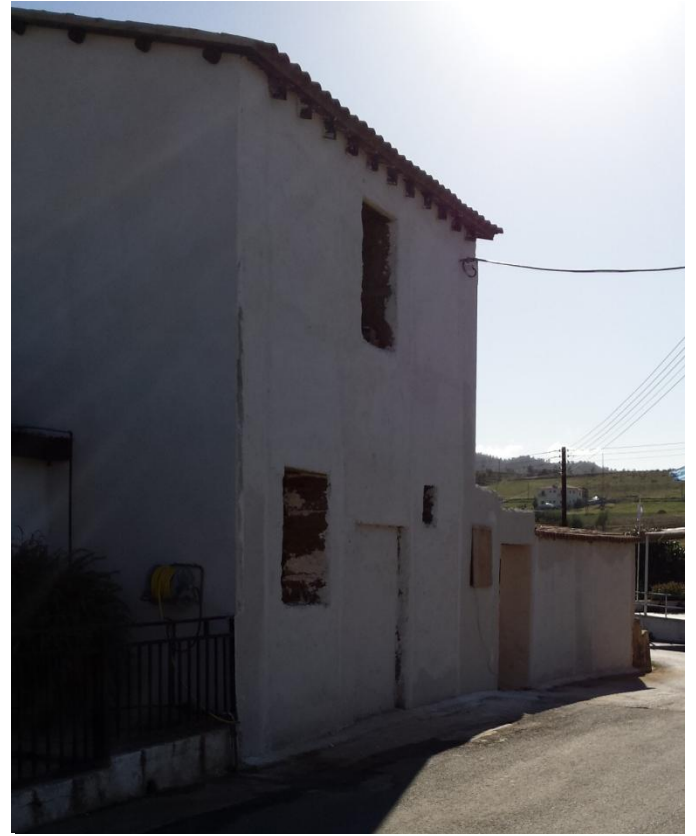
Εικόνα 125: Οικοδομή στο στάδιο της αποκατάστασης
