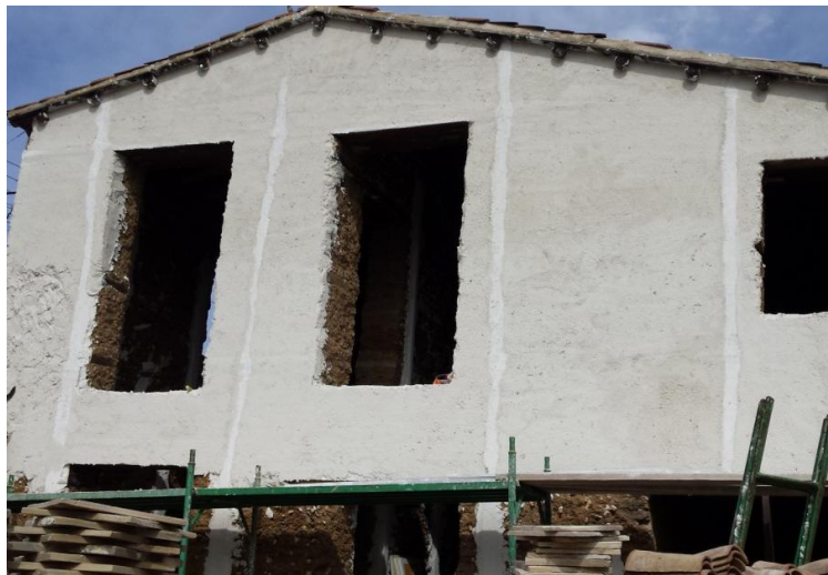
Εικόνα 115: Εφαρμογή επιχρίσματος στην πλινθοδομή
