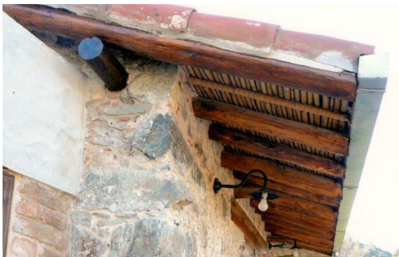
Εικόνα 19: Μορφή απόληξης στέγης με μεταγενέστερη επέμβαση
