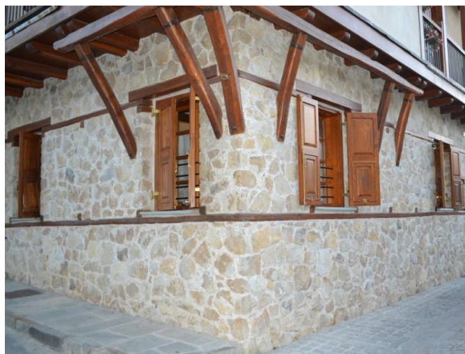
Εικόνα 99: Ξυλοδεσιές περιμετρικά της τοιχοποιίας
