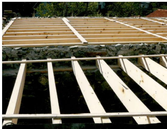
Εικόνα 39: Διαμόρφωση ξύλινου πατώματος με ξύλινα δοκάρια
