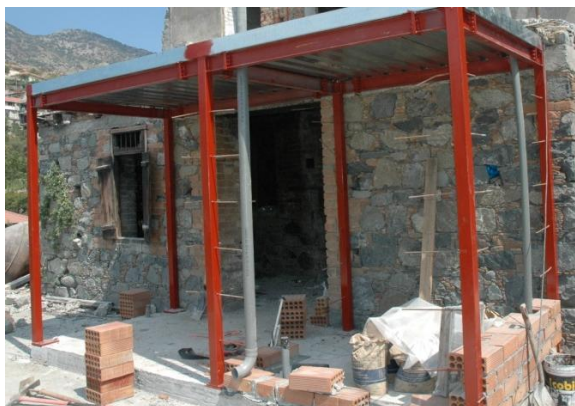
Εικόνα 81: Βάσιμο μεταλλικής κατασκευής
