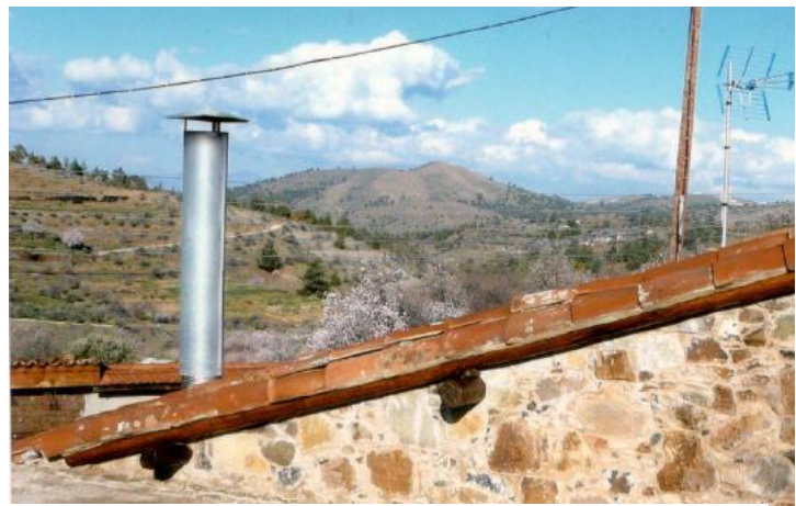
Εικόνα 71: Μεταλλικό φουγάρο σε διατηρητέα οικοδομή
