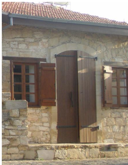
Εικόνα 47: Πρόσοψη οικοδομής με ξύλινα κουφώματα
