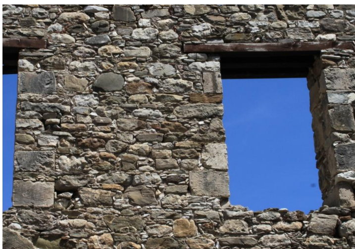
Εικόνα 5: Πέτρινη τοιχοποιία με χαλίκωμα
