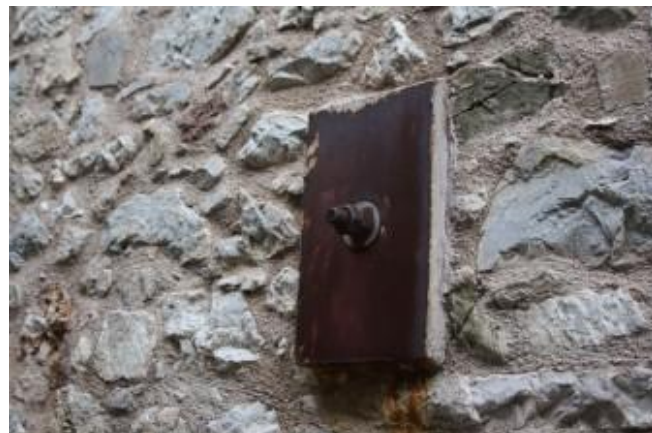
Εικόνα 74: Μεταλλικός ελκυστήρας
