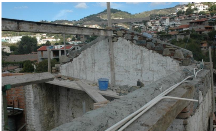
Εικόνα 22: Κατεδάφιση υφιστάμενης στέγης
