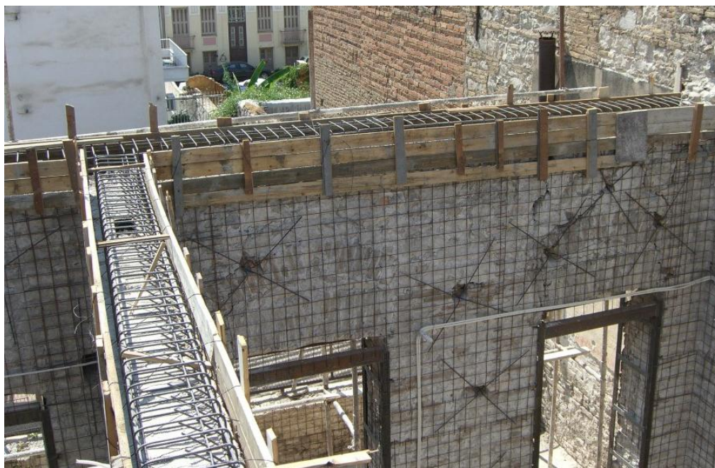
Εικόνα 97: Κατασκευή διαζώματος από οπλισμένο σκυρόδεμα
