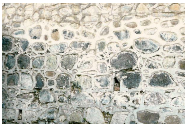
Εικόνα 2: Λιθοδομή με κονίαμα
