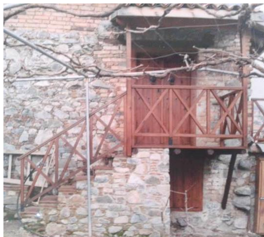
Εικόνα 61: Αποκατάσταση εξωτερικής πέτρινης σκάλας με ξύλινο πλατύσκαλο
