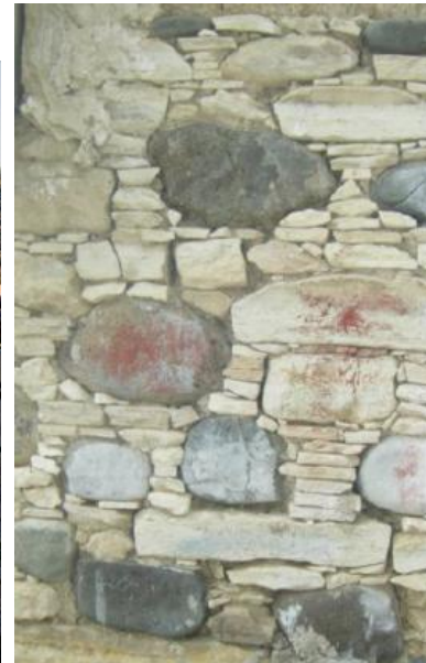
Εικόνα 4: Ιζηματογενή πέτρα και ανάμεικτα τοποθετημένες πέτρες του ποταμού
