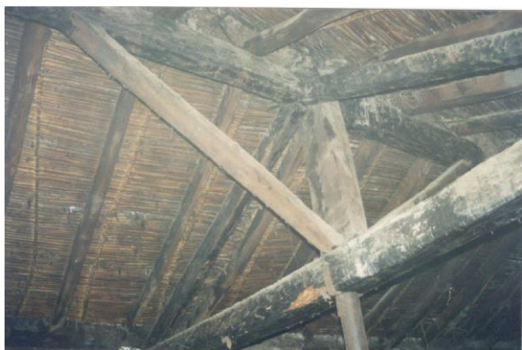
Εικόνα 31: Αρχική κατάσταση οροφής
