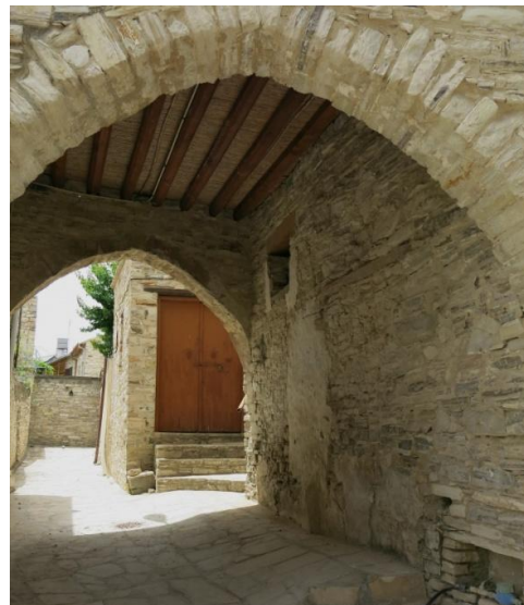
Εικόνα 58: Λιθόκτιστη καμάρα εξωτερικά της οικοδομής
