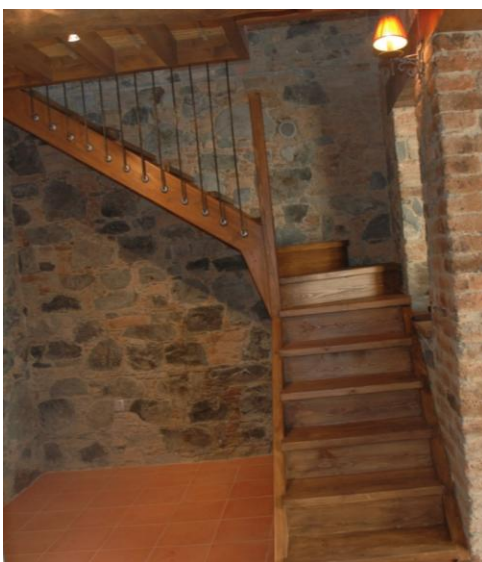
Εικόνα 59: Αποκατάσταση εσωτερικού κλιμακοστασίου
