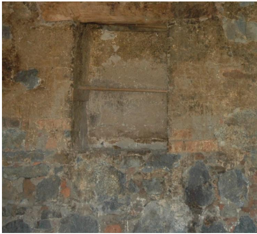
Εικόνα 63: Κούφωμα στην αρχική του μορφή
