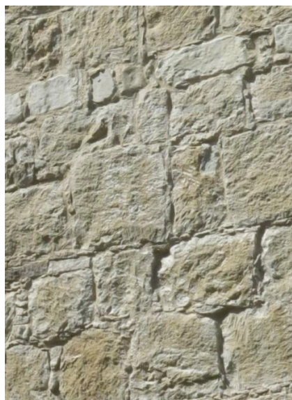
Εικόνα 10: Λεπτομέρεια λαξευτής πέτρινης τοιχοποιίας
