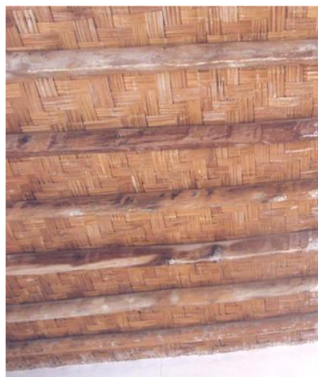
Εικόνα 18: Στέγη με ψάθα και βολίτζια
