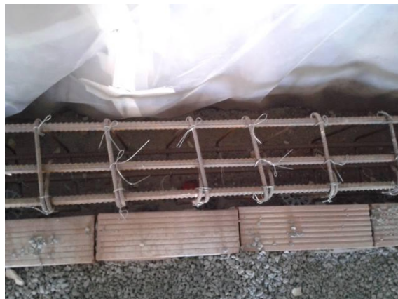
Εικόνα 117: Κατασκευή θεμελιοδοκών
