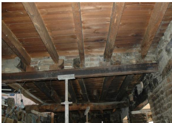
Εικόνα 40: Αρχική κατάσταση πατώματος με ξύλινες σανίδες και ξύλινες δοκούς
