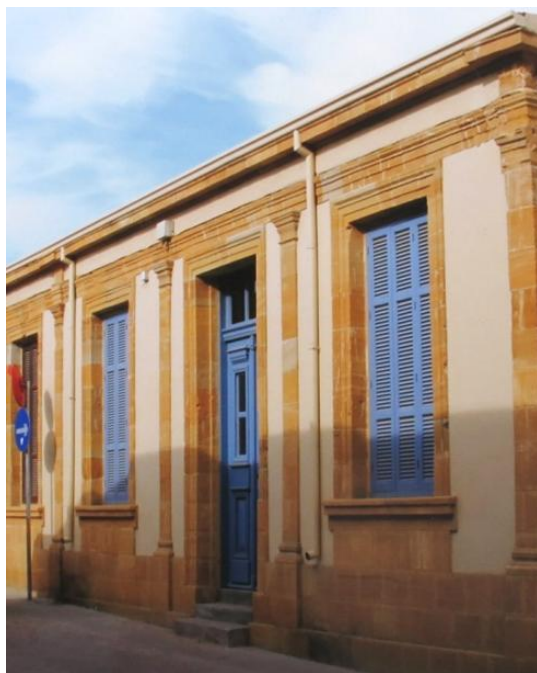
Εικόνα 13: Αποκατάσταση πρόσοψης με λαξευτή πέτρινη και επιχρισμένη τοιχοποιία
