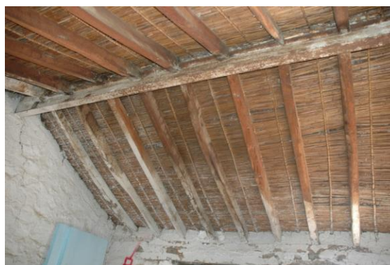
Εικόνα 21: Μορφή στέγης εσωτερικά
