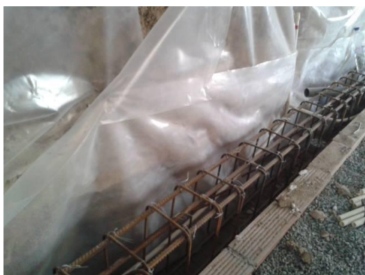
Εικόνα 118: Θεμελιοδοκοί
