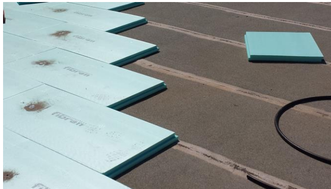
Εικόνα 2: Εφαρμογή εξηλασμένης πολυστερίνης οροφής
