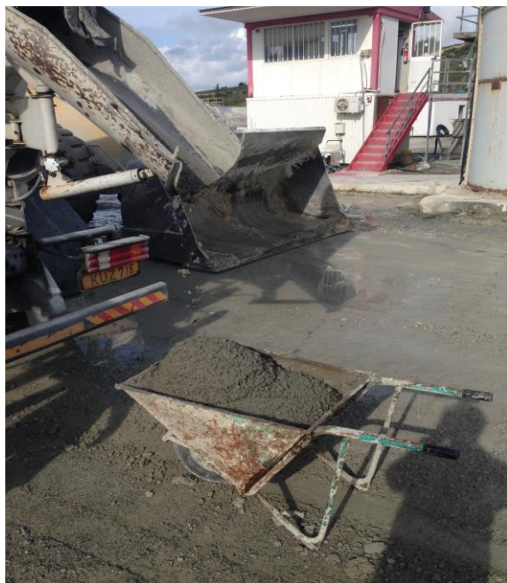
Εικόνα 3. Λήψη σκυροδέματος.
