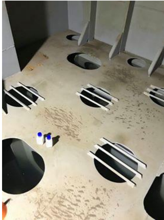
Σχήμα 3.8. Το εσωτερικό της δεξαμενής έρματος WBAPP του πετρελαιοφόρου πλοίου "Alexandria".
