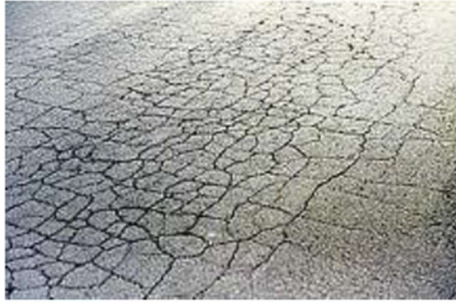
Εικόνα 1 Θερμική ρηγμάτωση εύκαμπτου οδοστρώματος
