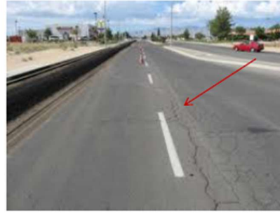
Εικόνα 1 Θερμική ρηγμάτωση εύκαμπτου οδοστρώματος
