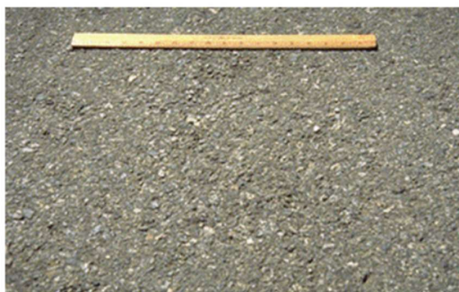
Εικόνα 4 Αποσάθρωση οδοστρώματος
