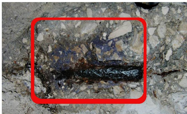
Εικόνα 66: Έλεγχος χλωριόντων ( http://sideris-konstantinos.blogspot.com )
