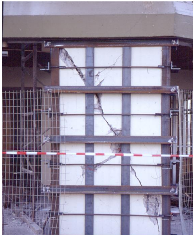
Εικόνα 74: Επέμβαση με μεταλλικό κλωβό για προσωρινή ανάληψη κατακόρυφων φορτίων (Δρίτσος 2005)
