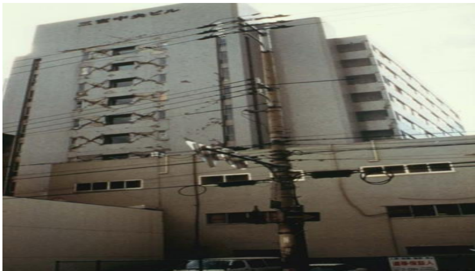
Εικόνα 49: Γ βαθμός βλάβης σε κτίριο με τοιχεία από οπλισμένο σκυρόδεμα ( https://eclass.uoa.gr )
