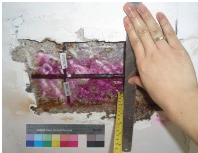
Εικόνα 64: Έλεγχος βάθους ενανθράκωσης ( https://www.concrepairs.gr )
