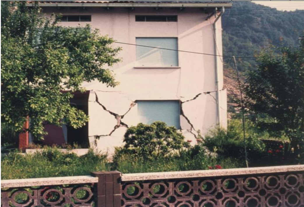
Εικόνα 45: Δ βαθμός βλάβης σε άοπλη τοιχοποιία ( https://eclass.uoa.gr )
