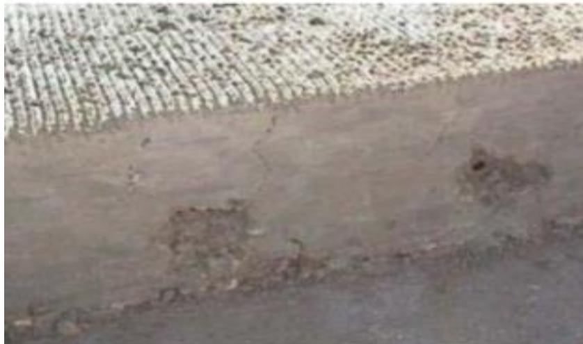
Εικόνα 34: Ρηγμάτωση λόγω πλαστικής συστολής ( https://docplayer.gr )
