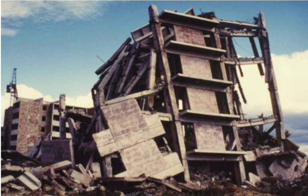
Εικόνα 46: Ε βαθμός βλάβης σε κατασκευή από οπλισμένο σκυρόδεμα ( https://eclass.uoa.gr )
