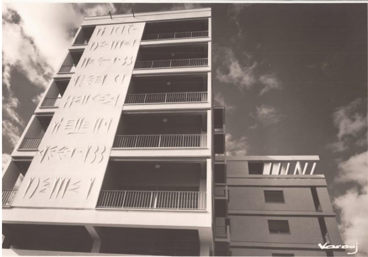
Εικ. 33: John Corbidge, Χωρίς τίτλο , 1969, ανάγλυφο με τσιμέντο. Πολυκατοικία Πίττα, Λεμεσός. Φωτογραφία του Varouj Voskeritchian (ιδιωτικό αρχείο Κώστα Κολακίδη)
