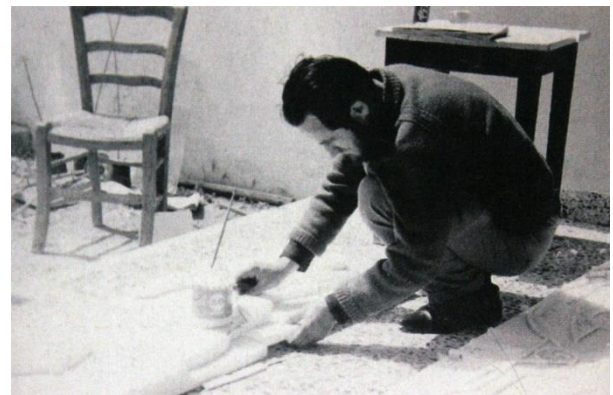
Εικ. 18: Ο Σάββα εν ώρα εργασίας για τη δημιουργία των καλουπιών πολυστερίνης στην Κισσόνεργα (1965)
